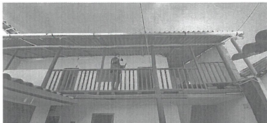
ELEMENTOS DE MADERA Y COBERTURA EN MAL ESTADO – RESIDENCIAL
