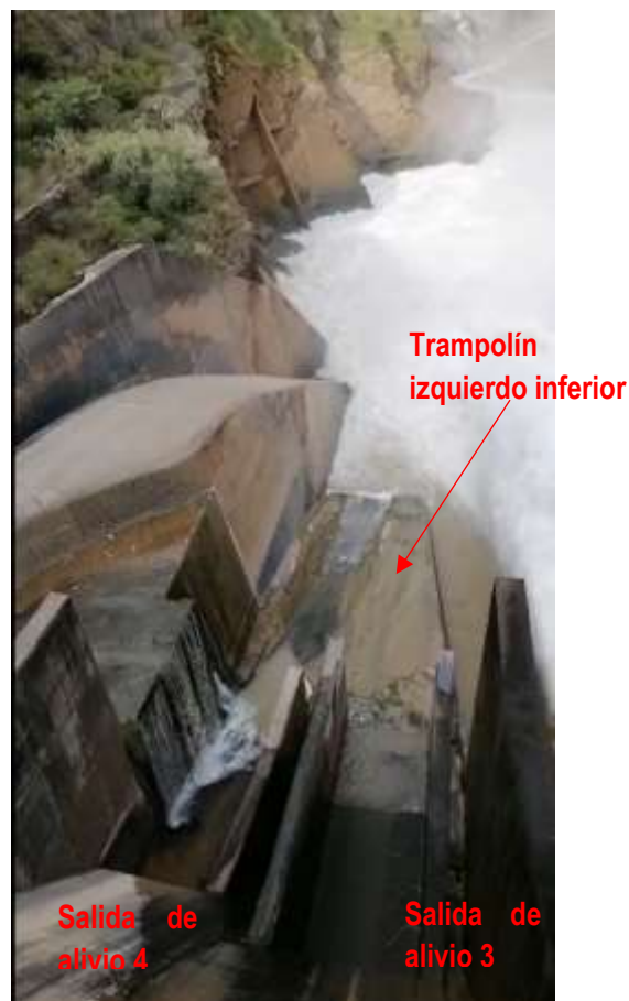
Figura 7 Salida del Alivio 4 y 3, aguas abajo de la Presa Tablachaca
