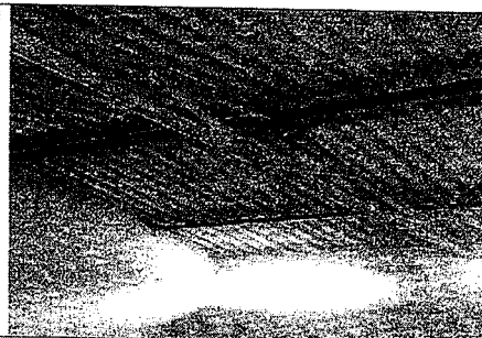
Foto N° 02: Se observa la cobertura de asbesto cemento con hueco en Almacén 2, es un ambiente a intervenir. La estructura de madera también en mal estado, muy antiguo apollillado a cambiar.
