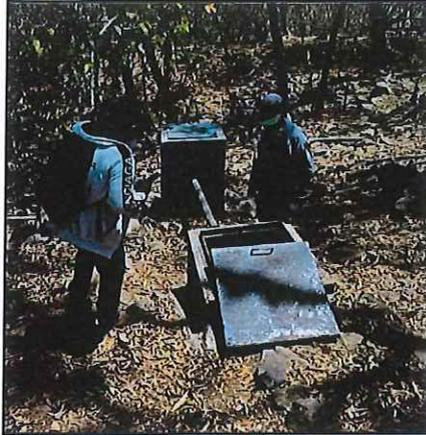
**Foto N°14:** Vista panorámica de la CRP existente del Caserío Chirinos, el cual presenta grietas y fugas causado por las fuertes lluvias durante el fenómeno del niño costero (FEN 2021). Requiere una rehabilitación urgente.
