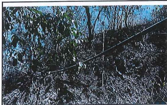
**FOTO N°10:** Vista panorámica de PA existentes L=20.00 ML en el Caserío Chirinos, expuesta a la intemperie y deteriorada en su mayoría y soportada con alambre N°08 en la totalidad de su luz.
