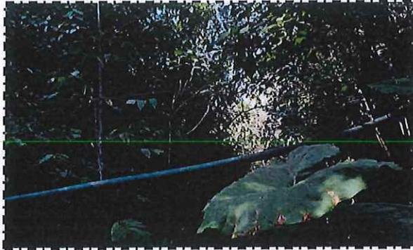
**FOTO N°09:** Vista panorámica de PA existentes de L= 50.00 ML en el **Caserío Chirinos**, expuesta a la intemperie y deteriorada en su mayoría y soportada con alambre N°08 en la totalidad de su luz.
