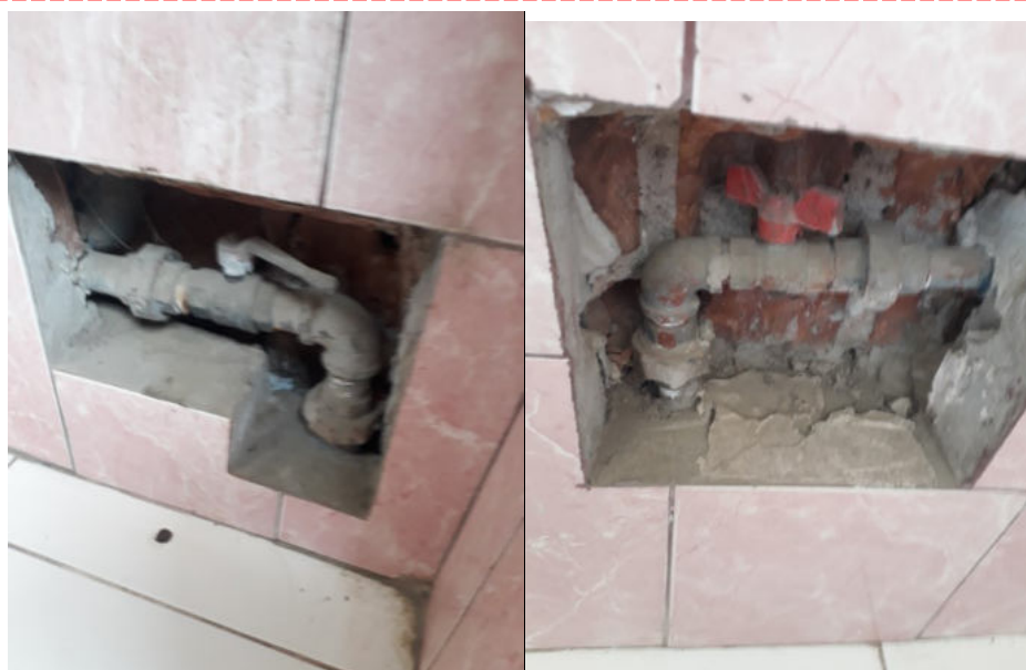
Fotografía 25: elevación 03 de los servicios higiénicos SSHH 1, M4. Se visualiza las 02 llaves de control en mal estado, sin tapa y con concreto sobre la tubería. La válvula de control de la foto derecha presenta dificultad para su manipulación.
