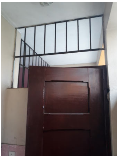
Fotografía 23: elevación 01 de los servicios higiénicos SSHH 1, M4. Se visualiza la puerta de ingreso al sshh de profesoras (damas). Los fierros de protección de la sobre luz se encuentran despintados y con posible presencia de óxido.
