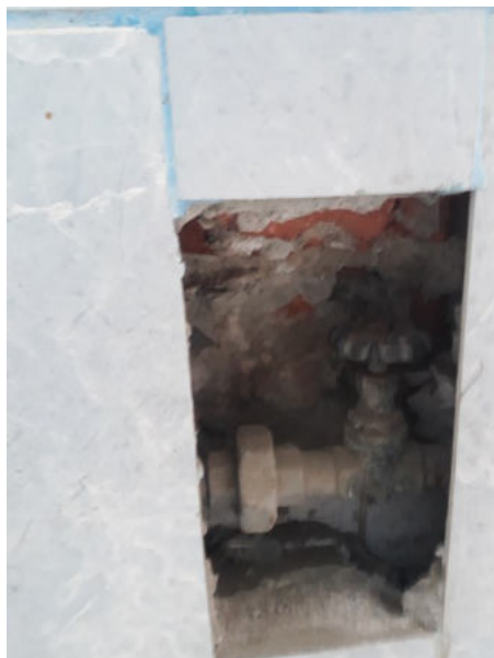
Fotografía 22: elevación 05 de los servicios higiénicos SSHH 1, M3. Se visualiza una llave de control en mal estado, sin tapa y con dificultad para el cierre.
