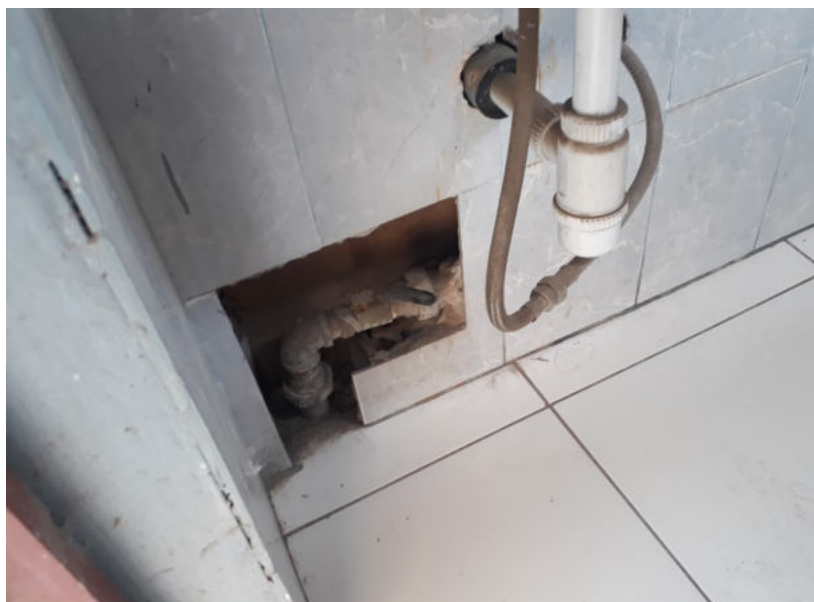
Fotografía 21: elevación 04 de los servicios higiénicos SSHH 1, M3. La válvula de control de agua sin tapa y con la llave oxidada.
