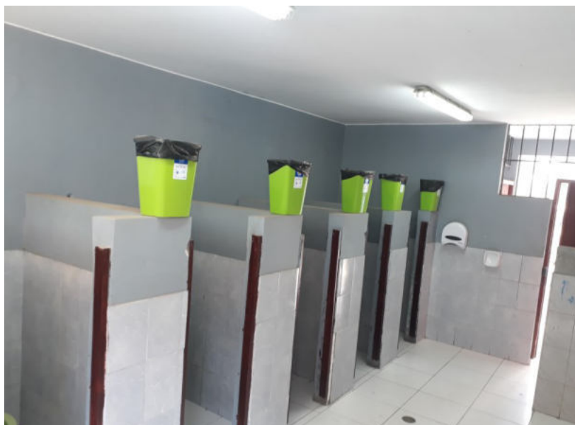
Fotografía 07: elevación 05 de los servicios higiénicos SSHH 1, M1. Las puertas de cubículos se encuentran despintadas y no tienen pestillos.
