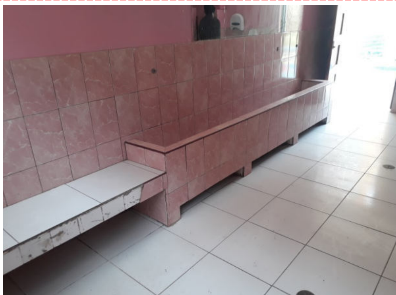
Fotografía 13: elevación 03 de los servicios higiénicos SSHH 1, M2. Se muestra la banqueta lateral al lavatorio con quiñado en su revestimiento. El lavatorio al tener un mandil muy bajo, no permite el mantenimiento de las tuberías de desagüe.
