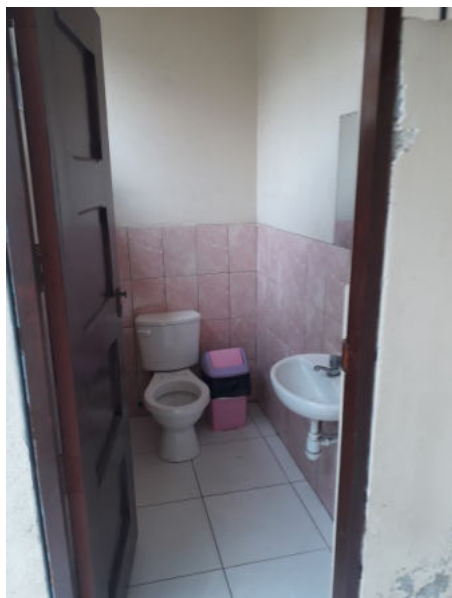
Fotografía 24: elevación 02 de los servicios higiénicos SSHH 1, M4. Se visualiza el buen estado de conservación en los revestimientos de pisos y paredes. Las grifería del lavadero, además de su tubería de abasto se encuentra oxidada.
