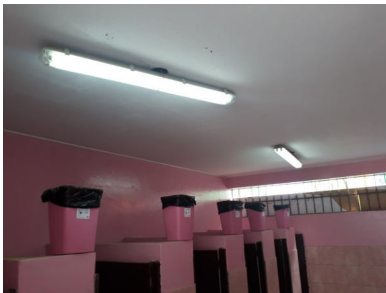
Fotografía 16: elevación 06 de los servicios higiénicos SSHH 1, M2. Las luminarias no son herméticas y no corresponden al uso de servicios higiénicos. Las rejas de protección en las ventanas se encuentran despintadas y con posible presencia de óxido.
