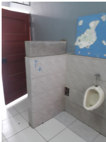
Fotografía 04: elevación 02 de los servicios higiénicos SSHH 1, M1. Se verifica el deterioro de la pintura en las paredes, enchapes con dos tipos en pisos por reparaciones posteriores, además de la tabiquería sin pintura en la parte superior no enchapada.
