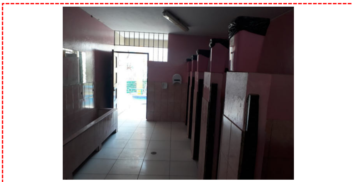
Fotografía 11: elevación 01 de los servicios higiénicos SSHH 1, M2. Se visualiza el buen estado del revestimiento del piso. La puerta de ingreso se encuentra en buen estado y las rejillas se encuentran despintadas y con posible presencia de óxido, además de no empalmar con el marco de madera de la puerta.
