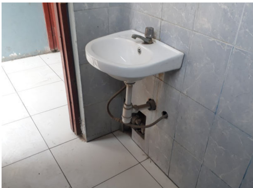
Fotografía 20: elevación 03 de los servicios higiénicos SSHH 1, M3. El lavadero cuenta con conexiones deterioradas, tuberías de abasto y grifería oxidadas.
