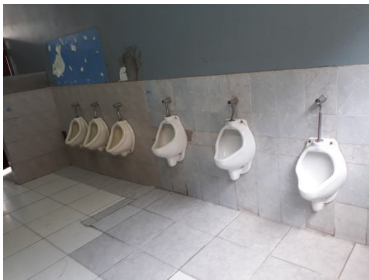
Fotografía 06: elevación 04 de los servicios higiénicos SSHH 1, M1. Los urinarios vistos en la izquierda, no mantienen el distanciamiento mínimo (60cm), las llaves de los urinarios se encuentran oxidadas. Se muestra el enchape del piso con dos tipos de cerámicos y dos tonos.
