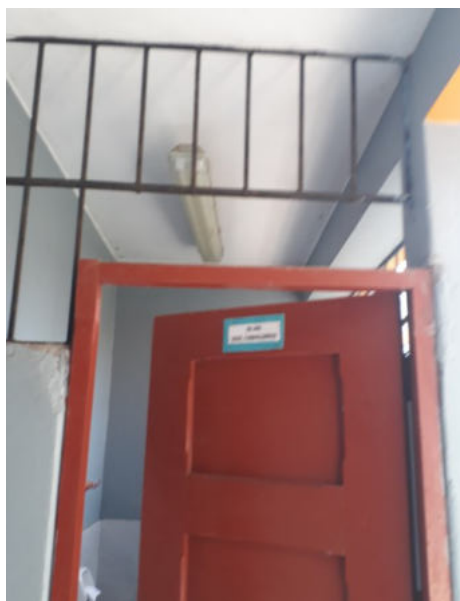
Fotografía 18: elevación 01 de los servicios higiénicos SSHH 1, M3. Se visualiza la puerta de ingreso al sshh de profesores, las rejas se encuentran despintadas y con posible presencia de óxido, además de no empalmar con el marco de madera de la puerta.
