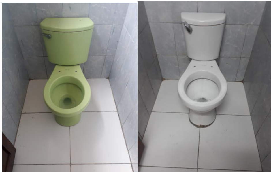
Fotografía 09: elevación 07 de los servicios higiénicos SSHH 1, M1. Se verifica que los 06 inodoros existentes se encuentran en buen estado y en funcionamiento. Las tuberías de abasto no consideran llaves angulares y faltan accesorios de uso como asientos para inodoros, dispensadores de papel.
