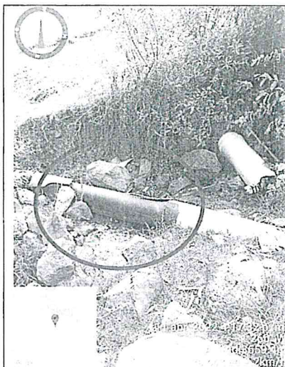
Fotografía N° 09: Tubería PVC expuesta al medio ambiente.
