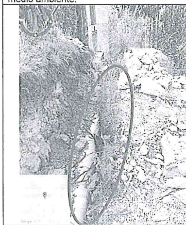
Fotografía N° 11: Tubería PVC expuesta al medio ambiente.
