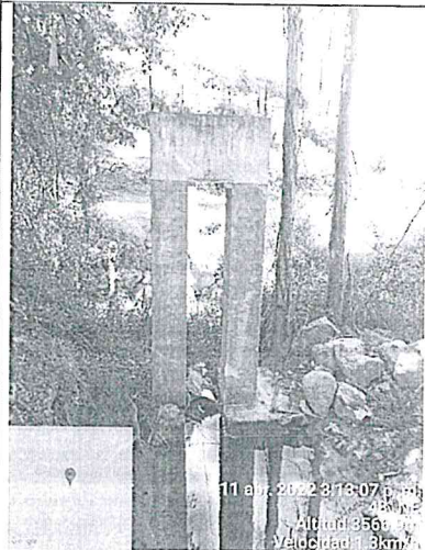
Fotografía N° 03: Pases Aéreos de diferente Longitudes se encuentran inconclusa solamente con zapatas y columnas.
