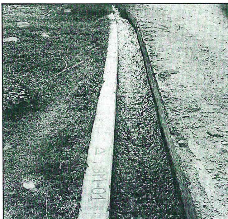
Fotografía N° 2: Canal revestido con concreto en mal estado
