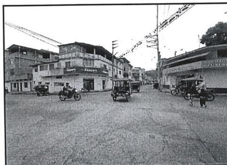
Vista de la C-03 y C-04 de la Calle Tupac Amaru Imagen 04: Se muestra el estado actual de la cuadra 03 (fin) y cuadra 04 (inicio) – intersección con calle San Carlos, paños totalmente agrietados, con bacheo y asentamiento.
