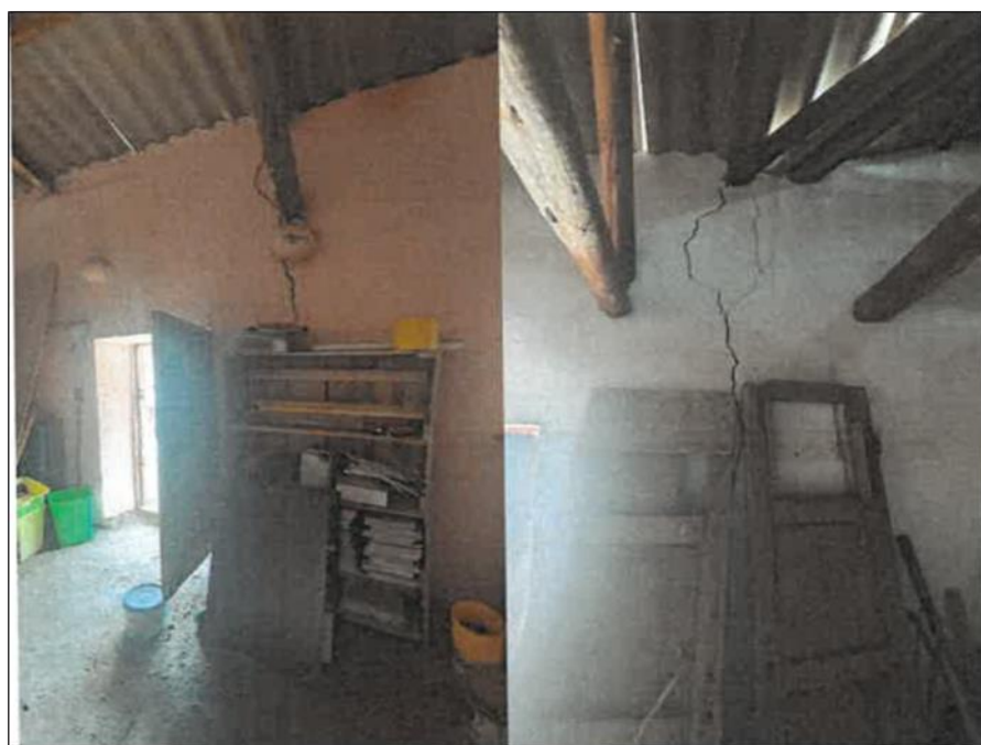
Vista fotográfica N°02: Infraestructura de material rústico, se visualiza fisuras en las paredes interiores
