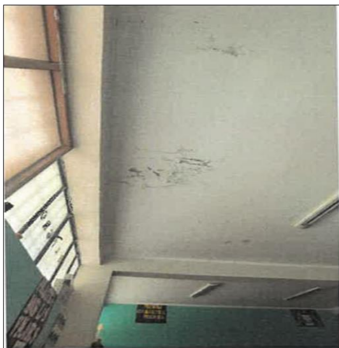
Vista fotográfica N° 10: Vista de filtraciones
