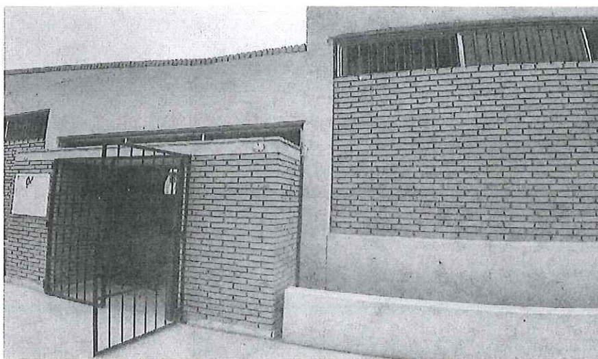
Puertas de acero tipo reja y protectores de ventana en mal estado.
