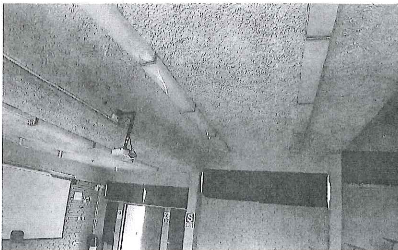
Escarchado en cielo raso a retirar.
