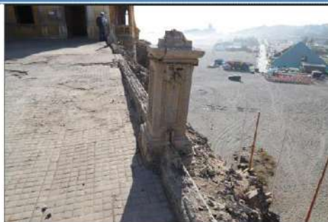
Vista de ingreso al Castillo Forga se aprecia también el mal estado de conservación del piso y de la baranda y ornamentación
