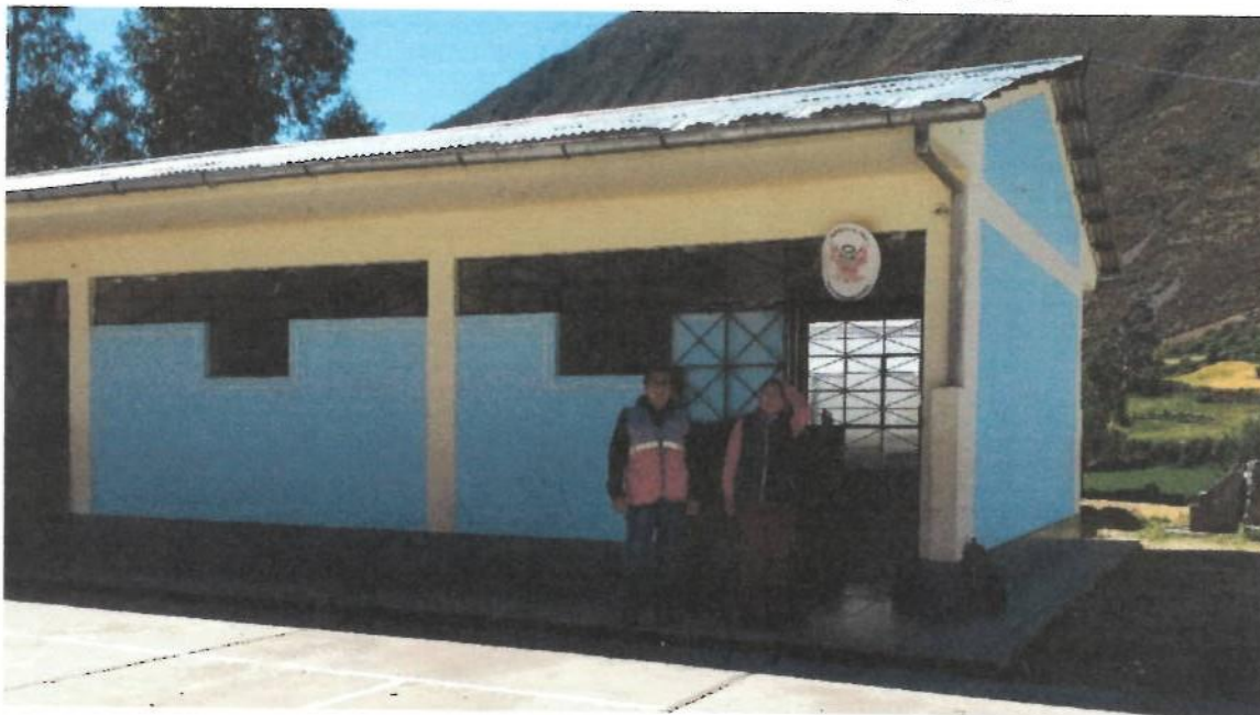
Foto N° 01: Vista exterior del pabellón, se encuentra en buen estado, no cuenta con sistema de drenaje pluvial.
