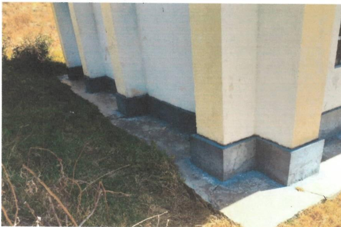
Foto N° 04: vista del exterior del pabellón, se observa fisuras en la vereda, presencia de humedad en la base de la pared, con desprendimiento del revestimiento, la edificación no cuenta con sistema de drenaje pluvial.
