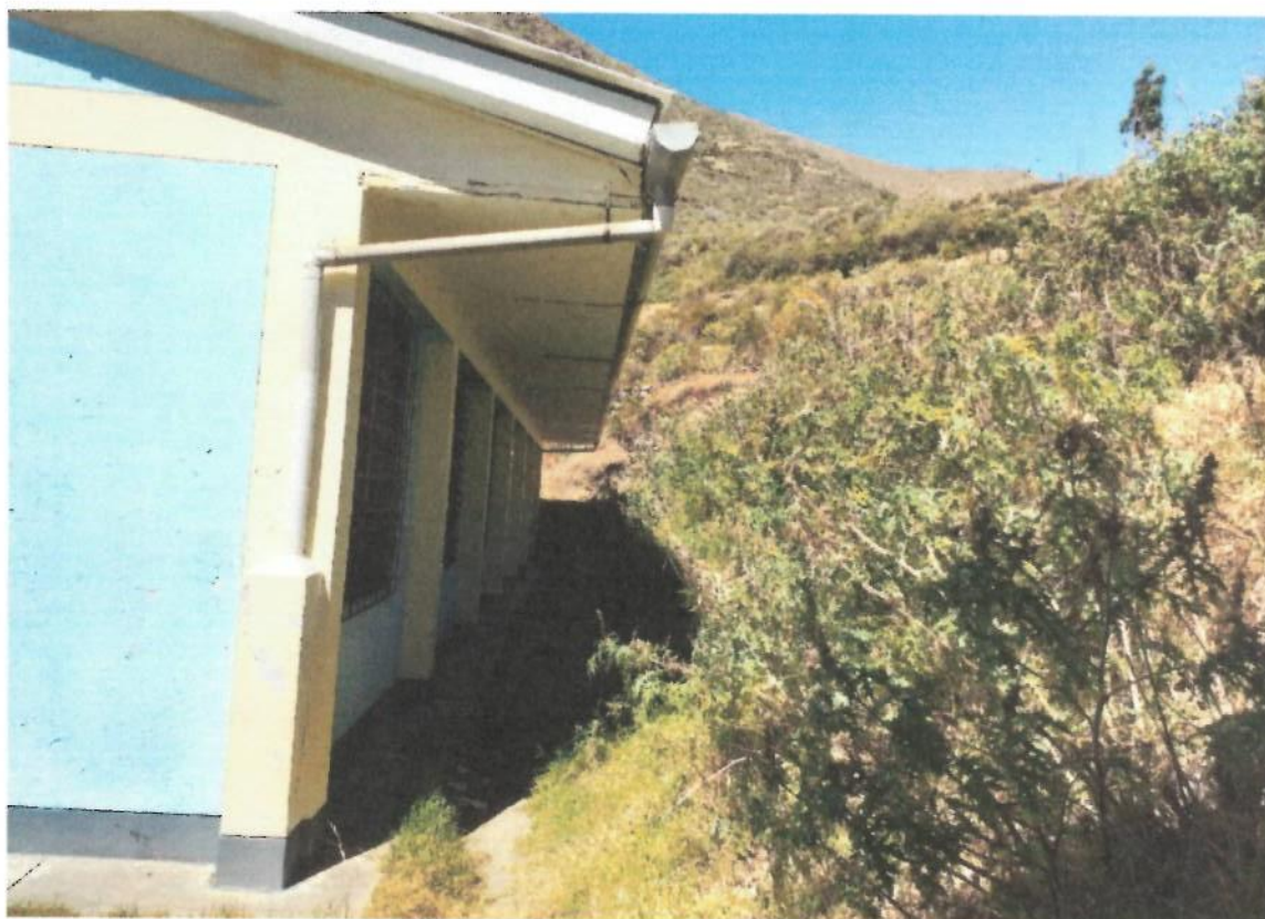
Foto N° 02: vista exterior de la parte posterior del pabellón, se observa que la edificación no presenta daño, no cuenta con adecuado sistema de drenaje.
