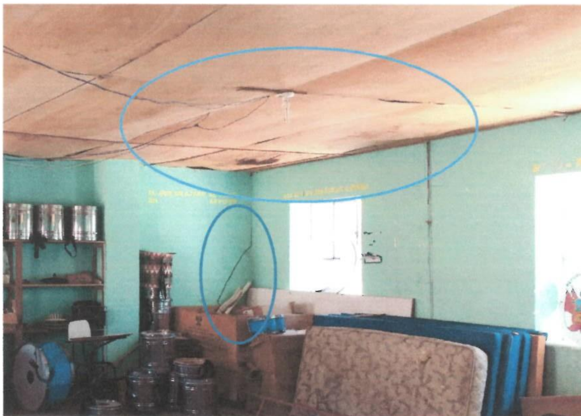
Foto N° 03: vista del interior de uno de los ambientes, se observa las grietas en la esquina en los amarres de ambas paredes que atraviesa todo el ancho de la pared, cielorraso de triplay deteriorado presenta filtraciones en el techo.
