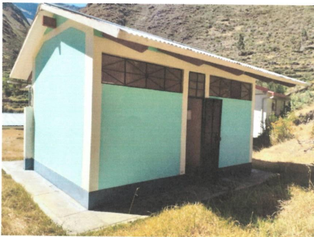
Foto N° 04: vista del exterior parte posterior del pabellón del ss.hh; no cuenta con sistema de drenaje pluvial (canaleta, cunetas).
