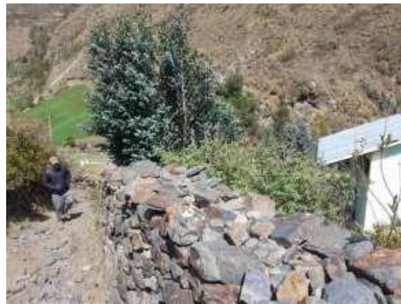
Foto N°02: Vista de un lado del cerco perimétrico construido con pirca de piedras, el cual no es seguro y puede causar accidentes en los niños.
