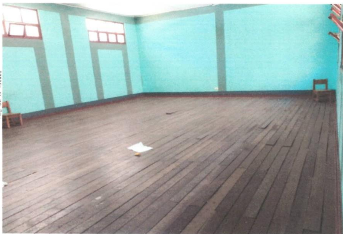
Foto N° 04: vista del interior de uno de los ambientes del pabellón, se encuentra en buen estado, requiere mantenimiento el entablado se tiene maderas arqueados y sueltos.
