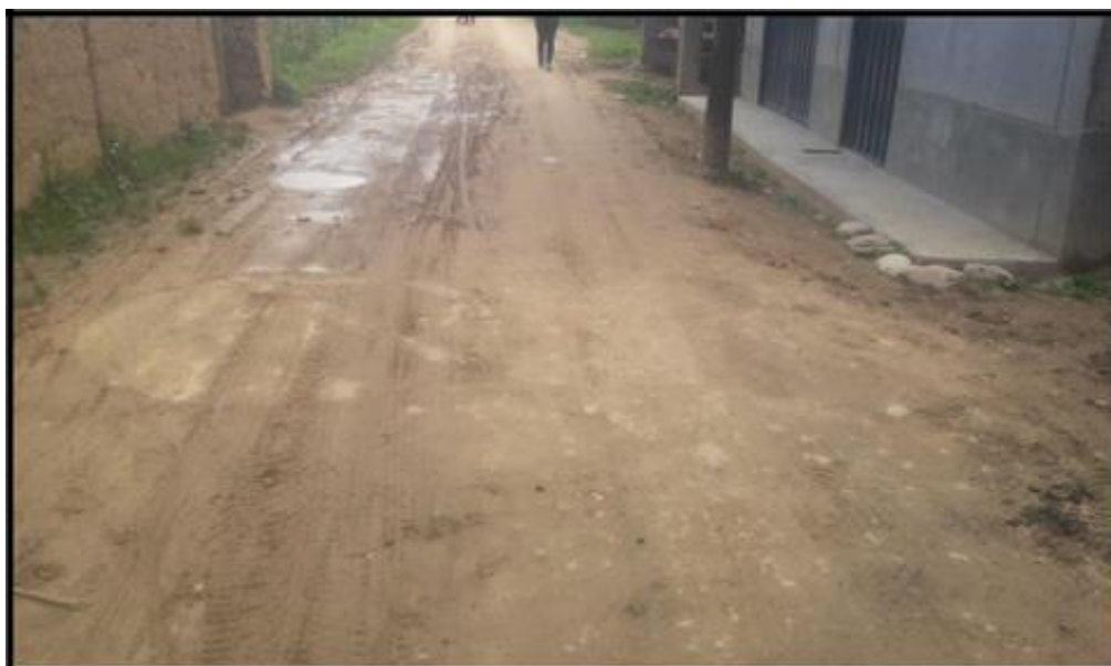
FOTOGRAFÍA N°04: Estado actual de la Calle 24 de junio Tramo II, se puede apreciar el mal estado a causa de las lluvias.
