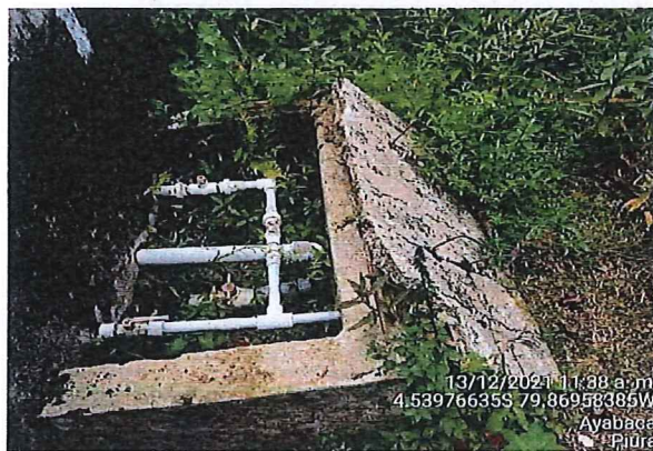
Figura 4. Caja de válvulas del reservorio existente en mal
