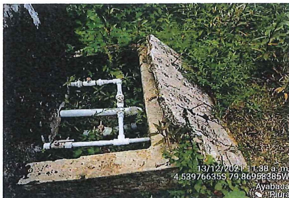
Figura 6. Caja de válvulas del reservorio existente en mal estado.
