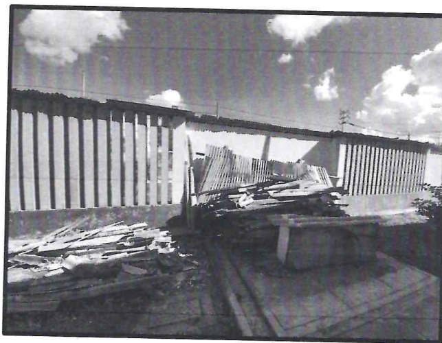
FOTO 06 – (08-06-2023) Se observa en la imagen los espacios en donde se esta implantando la puerta metálica en el muro de albañilería
