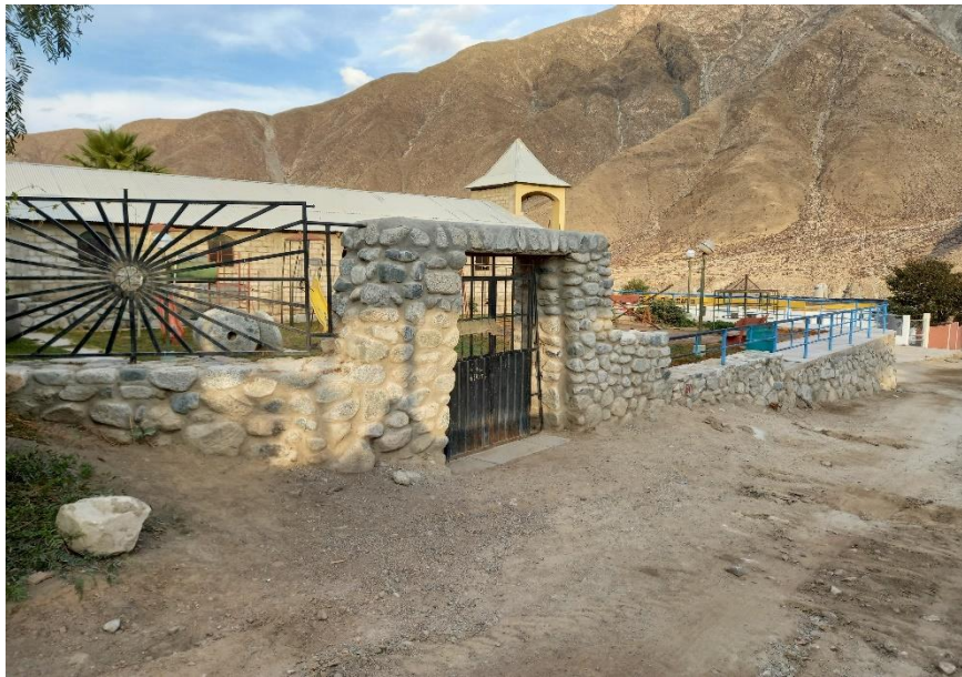
Imagen 5: Fachada Actual del Parque Infantil, se observa que el diseño de la Arquitectura no contrasta con el de un parque infantil. El estado de las barandillas y la reja es bueno estructuralmente, sin embargo, debido a su corta altura, es fácil el ingreso por estos lados. El proyecto renovara estas barandillas, por rejas altas que impidan el paso de personas ajenas que dañarían el mobiliario e infraestructura del parque infantil proyectado.
