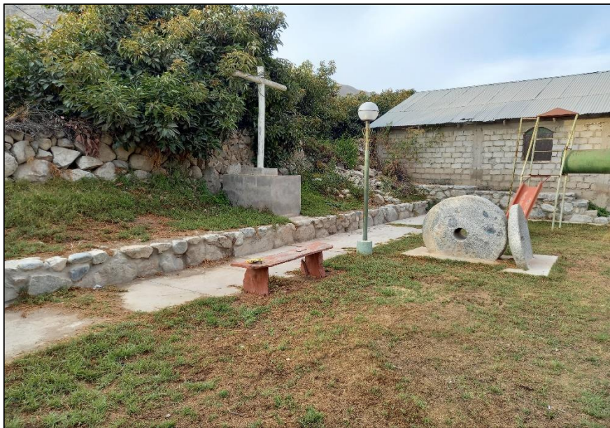
Imagen 3: Se observa el estado actual del Muro Seco del parque infantil, esta tenía función de contención del predio contiguo que es un terreno agrícola con cultivos de palta como se puede ver. Debido a las fuertes lluvias y movimientos sísmicos de la zona parte de este Muro se derrumbó como se observa en la parte del fondo. El proyecto plantea construir un nuevo muro de concreto ciclópeo y proyectar coberturas a los costados de la cruz.
