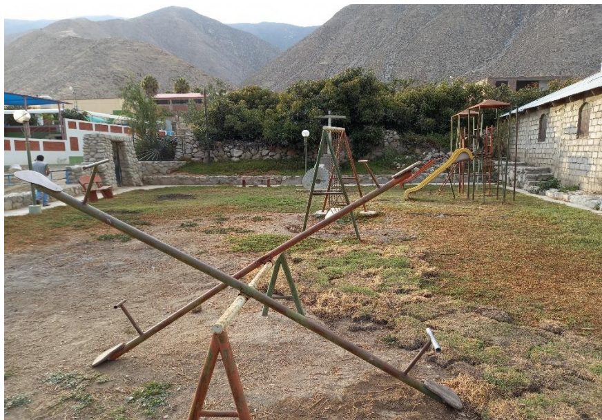
Imagen 4: En esta imagen panorámica se observa la amplitud del parque infantil y el estado en el que se encuentra, en la parte del fondo se observa el muro seco de piedra colapsado, en la céntrica los juegos los resbalones destruidos, las armaduras dobladas, los tubos metálicos oxidados, y finalmente el césped completamente deteriorado. El proyecto renovará todo lo visto, desde el césped por grass sintético, los juegos infantiles, la construcción de la glorieta en el centro, la construcción del muro de contención del fondo, el enrejado de toda la parte abierta del parque, el pañeteo y encalado del muro de bloqueta de la derecha, el pintado general de todo, entre otros puntos descritos en la ficha técnica.
