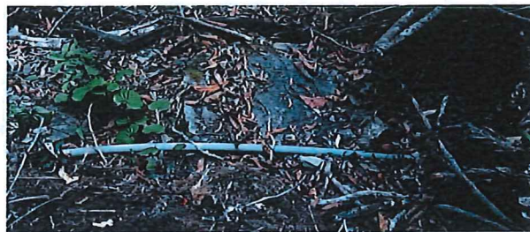
Vista 01: Tubería expuesta en Línea de conducción
