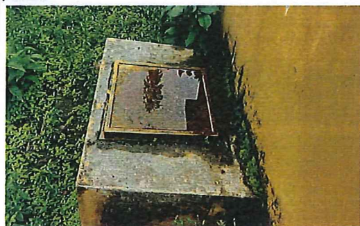
Vista 01: Caseta con Tapas oxidadas y presencia de eflorescencia interna y externa
