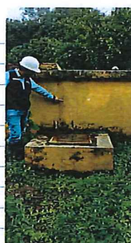
Vista 02: Cuba con presencia de filtración en estructura y salitre en paredes
