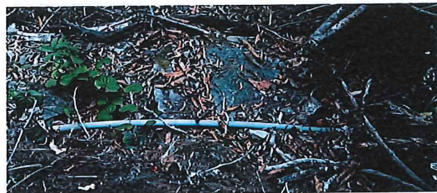
Vista 01: Tubería expuesta en Línea de conducción
