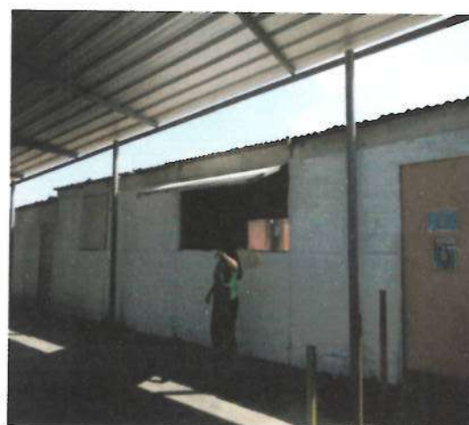
Foto N° 04 y 05: Vista frontal de edificación de triplay con ventana levadizas para ventilación
