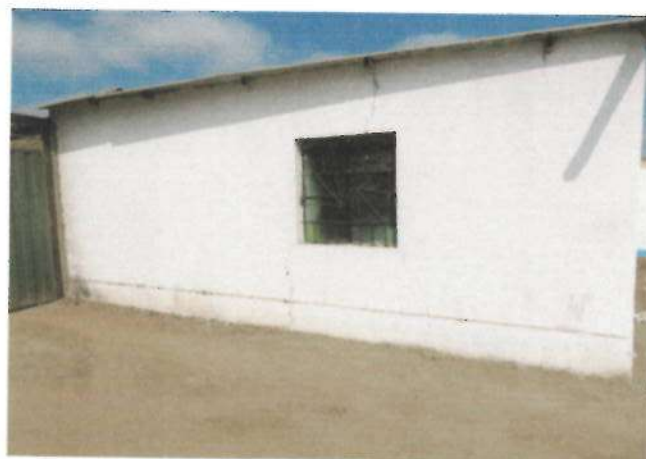
Foto N° 04: Vista de fisuras en muro exterior de edificación
