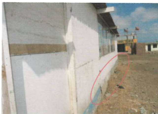
Foto N° 02: Vista exterior de aula parte inferior deteriorada por humedad
