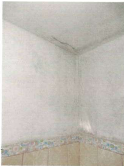
Foto N° 04: Se observa fisuras verticales en muro
