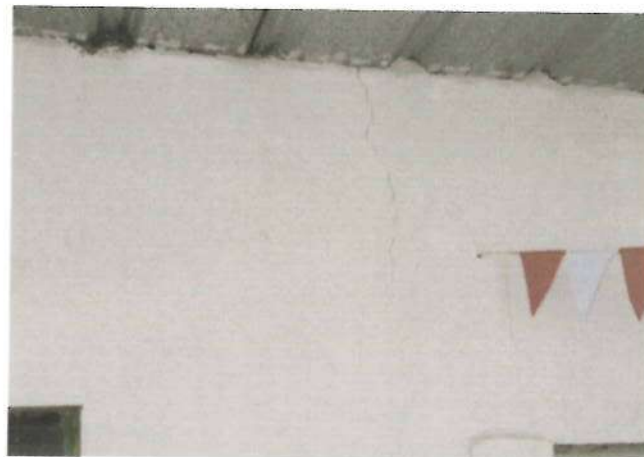
Foto N° 02: Vista de fisuras en muro de aula
