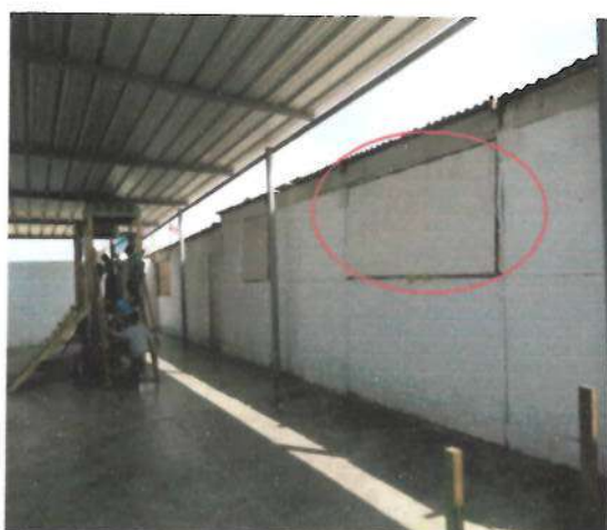
Foto N° 04 y 05: Vista frontal de edificación de triplay con ventana levadizas para ventilación
