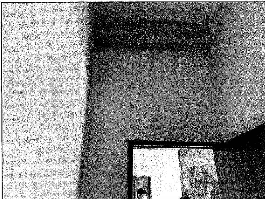
**Foto 05:** Presencia de grietas en muros, siendo necesario el picado y resane.
