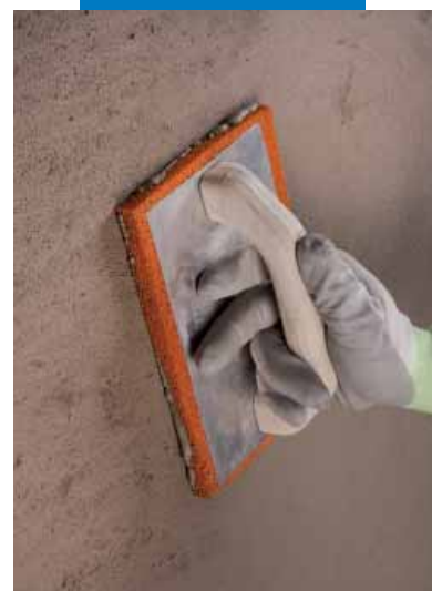
Fratasado de Planitop Rasa & Ripara
