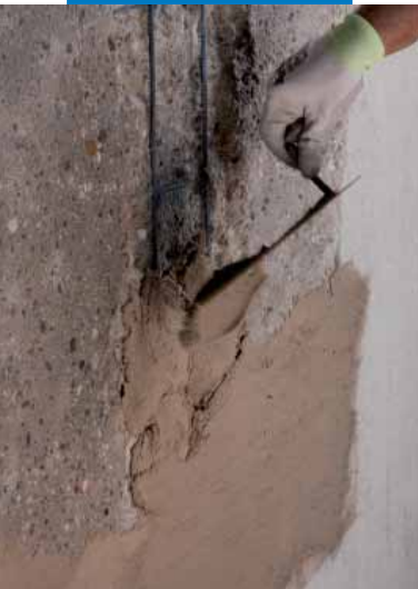
Aplicación con paleta de Planitop Rasa & Ripara
