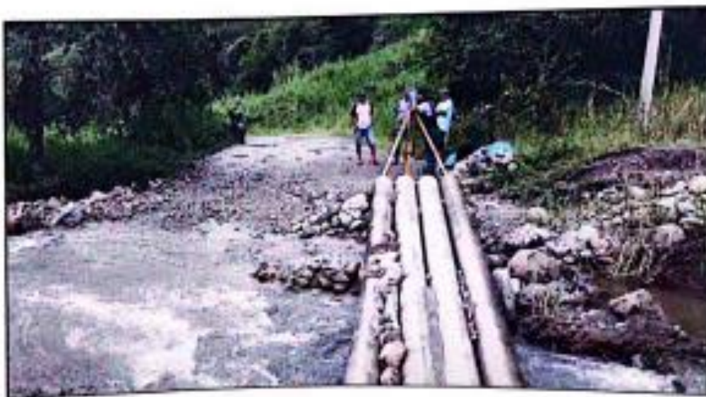
Figura N° 5: Vista de las vigas de postes de concreto deterioradas.
