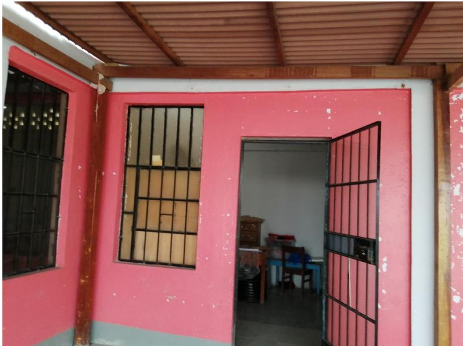
**COCINA:** Se aprecia un ambiente que viene siendo utilizada como cocina en un área de 3.68 m<sup>2</sup>. Este ambiente es de material precario, sin características técnicas y los alimentos e insumos de cocina se encuentran expuestos. Los muros de triplay con madera, techo de fibraforte. Este ambiente no adecuado para la función que se le ha otorgado. Es necesario su nueva construcción.
