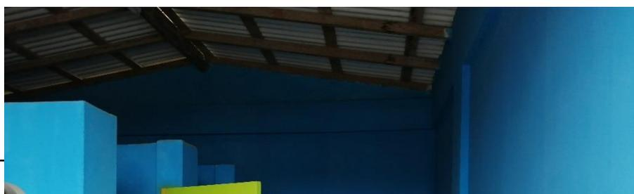
**ALMACÉN O DEPÓSITO:** Existe un almacén o depósito que se encuentra ubicado dentro de las instalaciones de los servicios higiénicos, el mismo que es anti reglamentario, tiene un área de 12.63 m<sup>2</sup>, es de material noble con piso de concreto. La cobertura es de fibraforte gran onda de polipropileno con vigas de madera y está en mal estado, recomendando su traslado a otro ambiente.
