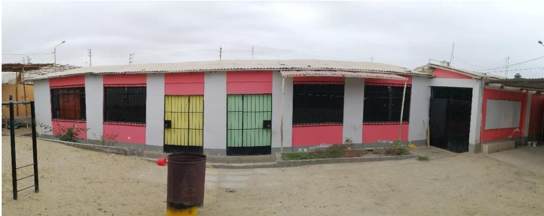
**DIRECCIÓN:** Se cuenta con 01 ambiente de un solo nivel, es de material noble, piso de concreto, no está equipada, pero si cuenta con mobiliario inapropiado para este ambiente, el área es muy hacinada. Mide 19.70m<sup>2</sup>. Techo cobertura de fibrocemento con vigas de madera. El sistema eléctrico se encuentra en condiciones regulares.
