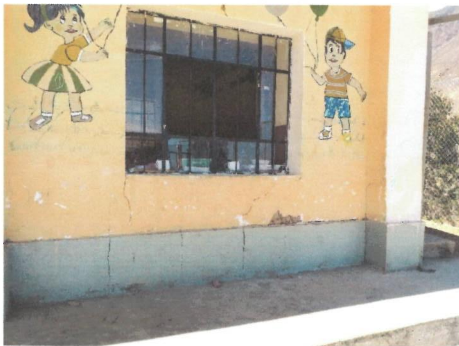
Foto N° 01: vista de la edificación, presenta fisuras en las paredes de adobe.
