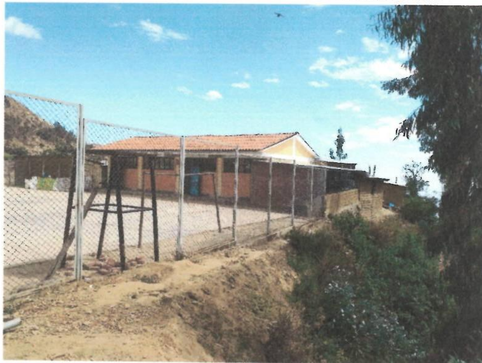
Foto N° 01: vista de un tramo del cerco perimétrico construido con parantes metálicos y malla olímpica, se encuentra en buen estado.
