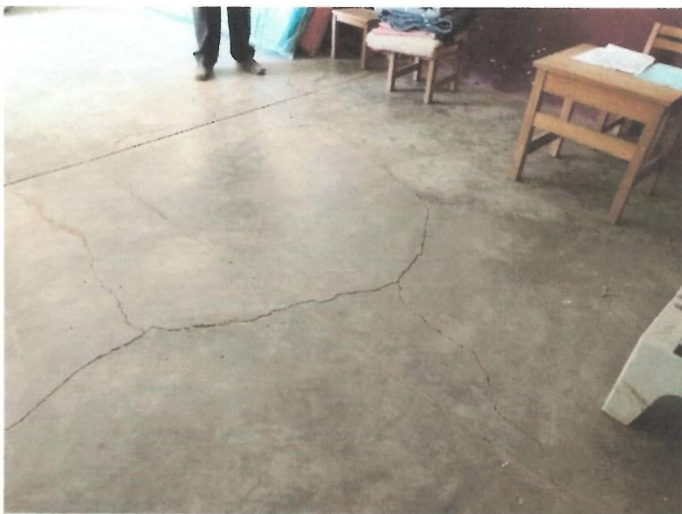
Foto N° 04: vista del interior de uno de los ambientes, presenta fisuras en todo el piso de concreto.
