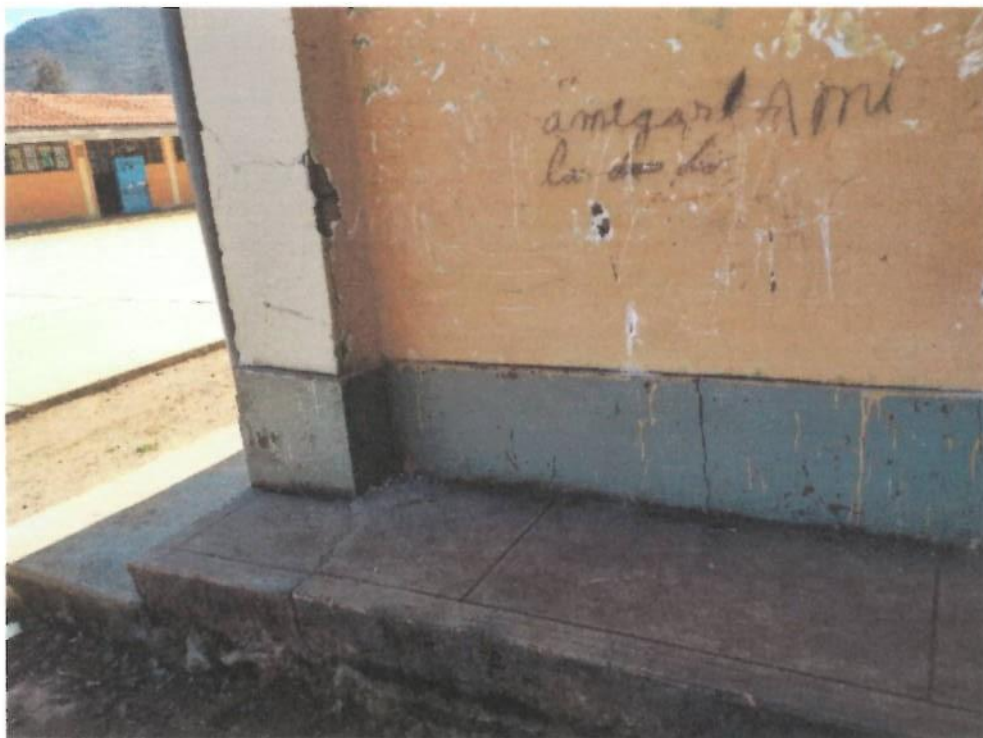
Foto N° 03: vista del exterior de la edificación, presenta fisuras grietas en veredas, desprendimiento del tarrajeo de la parte baja de la pared por la presencia de humedad y el deterioro del adobe.
