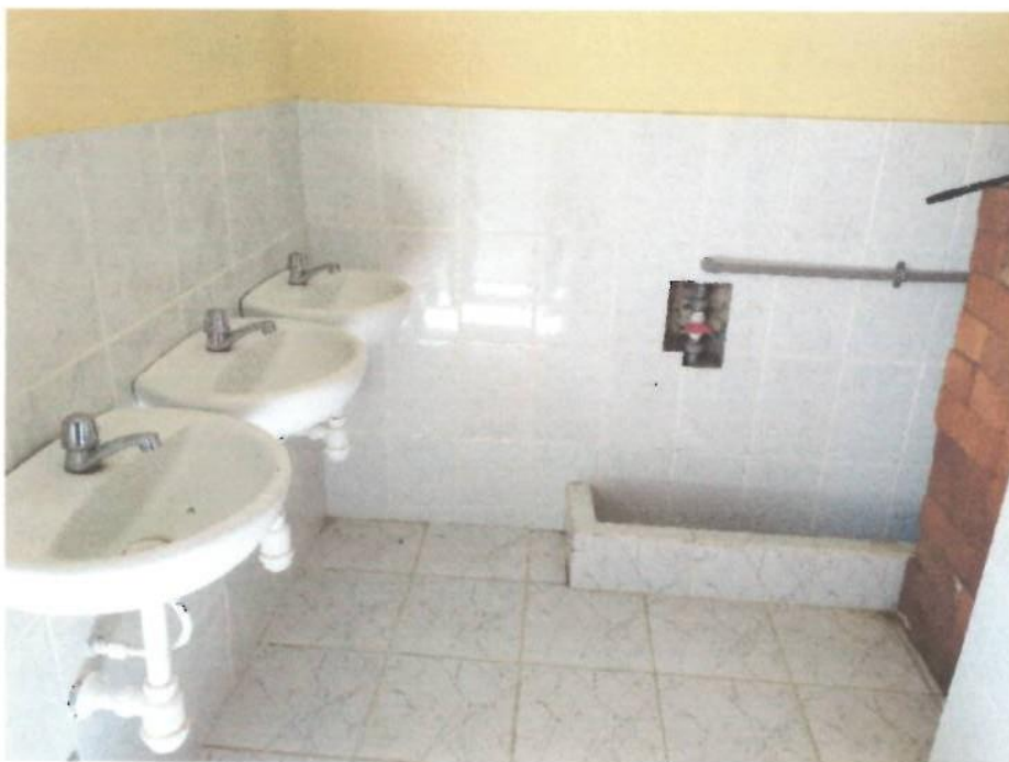
Foto N° 02: vista del interior del servicio higiénico, se encuentra en buenas condiciones, sin embargo, no cuentan con agua permanente, el suministro del agua es de la red pública, tienen problema con el abastecimiento de agua debido a la poca cantidad de agua que se suministra a la red pública.
