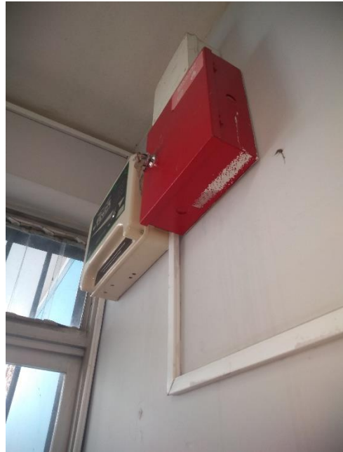
Foto N°14 El panel de alarmas contra incendios debe conectarse al sistema de puesta a tierra su gabinete metálico,
