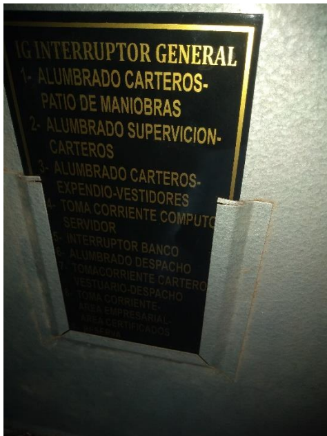
Foto N°03 Se observó que la leyenda o directorio del tablero del primer piso o tablero general se encuentra sin actualizar (circuito 5 figura como "Interruptor Banco, debe decir interruptor
