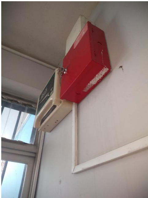
Foto N°11: Se observa el panel de alarmas contra incendios instalado a una altura no adecuada, deberá ser instalado a una altura maniobrable con la base superior a una altura máxima de 1.8 mt, asimismo se observa que dicho panel se conecta eléctricamente a través de un tomacorriente cercano. Dicho panel debe conectarse a un circuito independiente directamente desde el tablero eléctrico
