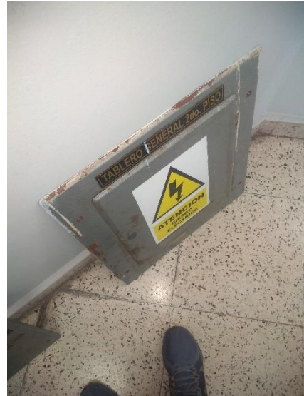
Foto N°02: Se observó que los gabinetes metálicos de los tableros eléctricos tanto del primer piso como de segundo piso se encuentran en mal estado de conservación presentan oxido en sus cuerpos metálicos
