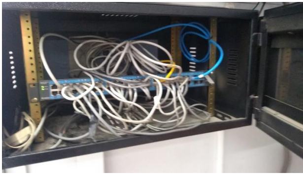
Foto N°13: Se observa racks de comunicaciones sin aterrar
