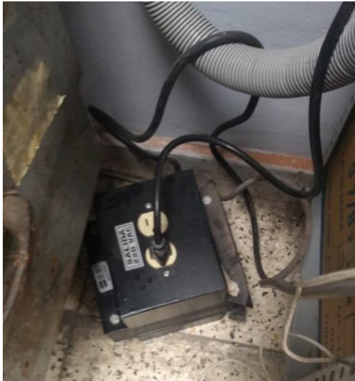
Foto N°09: Se observa muebles metálicos en donde se tiene equipos eléctricos sin conexión a tierra, transformador sin conexión a tierra, asimismo equipos de iluminación sin conexión a tierra
