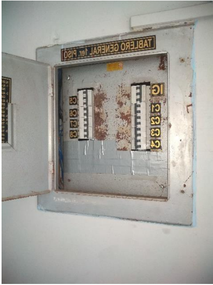
Foto N°1 Se observó que los gabinetes metálicos de los tableros eléctricos tanto del primer piso como de segundo piso se encuentran en mal estado de conservación presentan oxido en sus cuerpos metálicos
