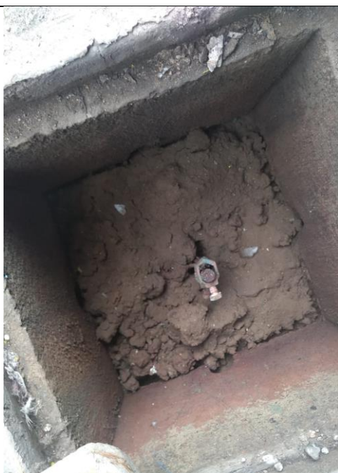
Foto N°19: Los componentes del pozo a tierra presentan oxido, conector y varilla en mal estado de conservación
