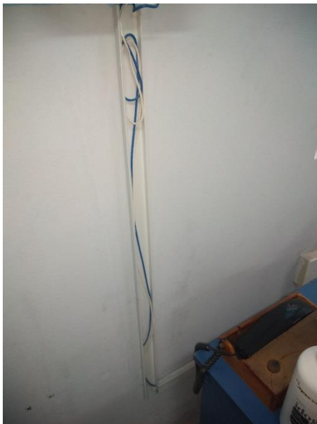
Foto N°15: Se observa cables eléctricos expuestos en canaletas sin tapa protectora
