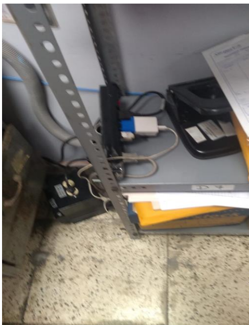
Foto N°07: Se observa extensiones sobrecargadas conectadas a tomacorrientes en oficinas, estabilizadores sobrecargados conectados a tomacorrientes
