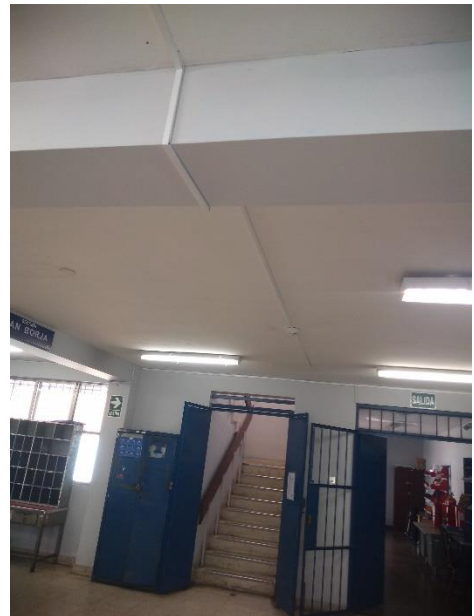
Foto N°12 Se observa que las canalizaciones para los detectores de humo son a través de canaletas de PVC. Dichas canalizaciones deberán ser de tubería metálica
