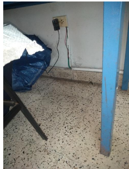
Foto N°16: Se observa cables eléctricos expuestos en canaletas sin tapa protectora
