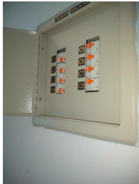
Foto N°04 Actualizar leyenda del tablero de interruptores diferenciales, ya que el diferencial 5 es reserva
