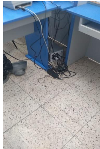
Foto N°06: Se observa extensiones sobrecargadas conectadas a tomacorrientes en oficinas, estabilizadores sobrecargados conectados a tomacorrientes
