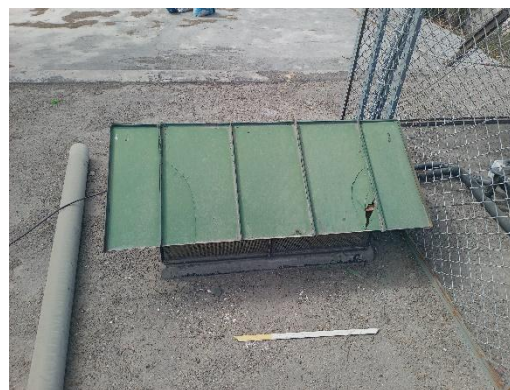
Figura 28: Algunas piezas de vidrio en claraboyas poseen fisuras, presencia de mallas en la parte baja de claraboyas permite el paso del agua a los espacios interiores.
