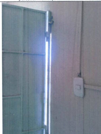
Figura 15: Conservatorio de Cadáveres 2: Sistema eléctrico expuesto, accesorios de iluminación mal colocados.
