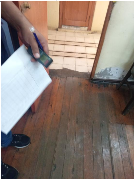
Figura 23: Jefatura: Zócalo de madera desprendido, pintura de paredes en mal estado
