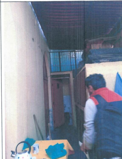
Figura 24: Pasillo-Almacén- Baño: deformación de cobertura de calamina, espacio sobre el baño con presencia de humedad y desprendimiento de pintura, ingreso de roedores, almacén sin seguridad en puertas.
