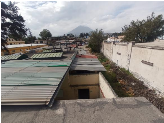
Figura 29: La cobertura se encuentran mal anclados a estructura metálica, por tanto se coloca peso sobre ellos.
