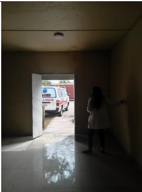
Figura 16: Conservatorio de Cadáveres 2: sistema eléctrico expuesto, techo y paredes con presencia de humedad, puerta metálica no corresponde al tamaño del vano ingresando plagas y polvo por espacios contorno a la puerta.
