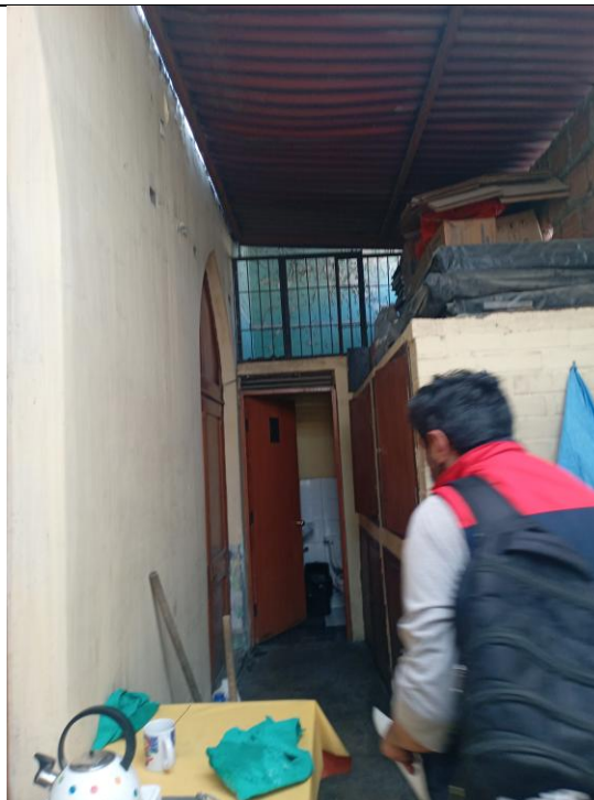
Figura 24: Pasillo-Almacén- Baño: deformación de cobertura de calamina, espacio sobre el baño con presencia de humedad y desprendimiento de pintura, ingreso de roedores, almacén sin seguridad en puertas.
