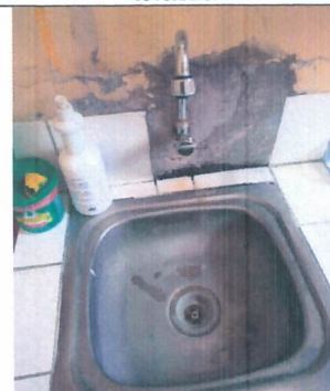
Figura 12: Laboratorio de Citopatología 1: poza de cocina no cumple con norma, presencia de varias juntas en mesada impide una adecuada limpieza, ausencia de piezas de revestimiento de mueble de concreto, pintura deteriorada.
