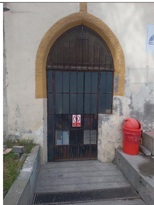
Figura 26: Ingreso depósito de cadáveres1: Carpintería metálica con presencia de oxido, según área usuario regularmente los visitantes rompen vidrios de la puerta, y el drenaje pluvial conjunto resume en época de lluvias.
