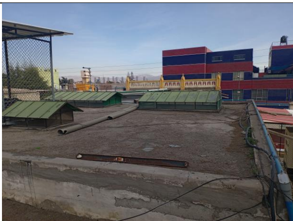
Figura 27: Techos con cableado expuesto y basura de material y de arboles.
