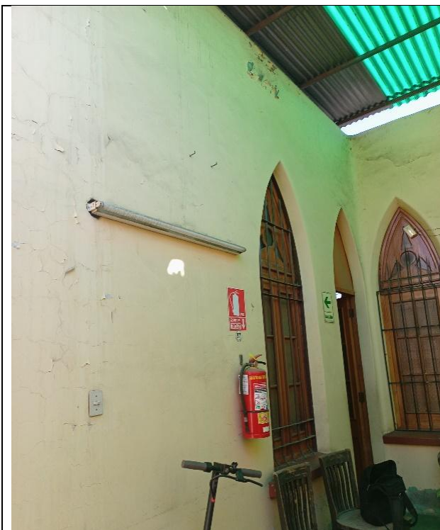
Figura 09: Patio: Pintura deteriorada por lluvia, Estructura metálica con presencia de oxido. Puertas y Ventanas de carpintería de madera deterioradas.
