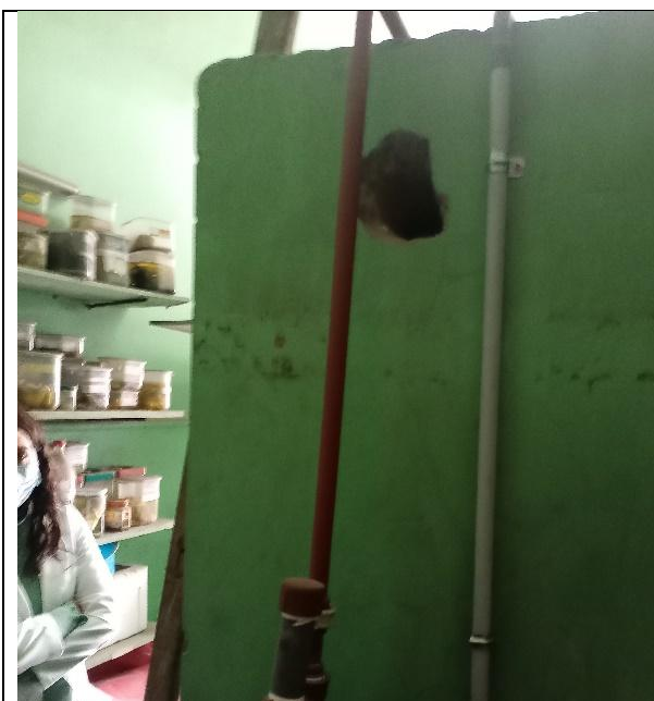
Figura 17: Depósito de Cadáveres 1: Pintura deteriorada, acabados gastados, instalaciones expuestas.
