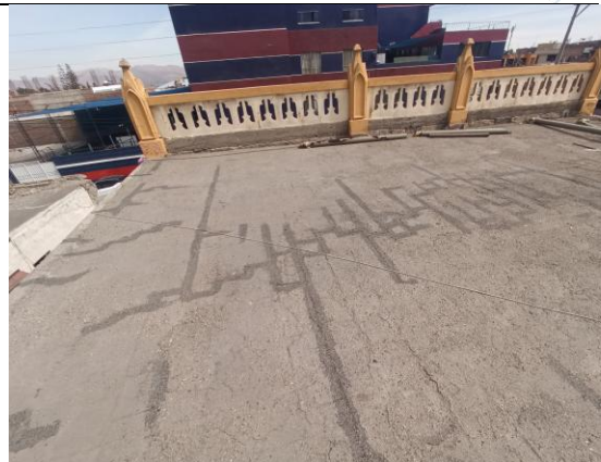
Figura 30: Impermeabilización de techos realizada con brea.
