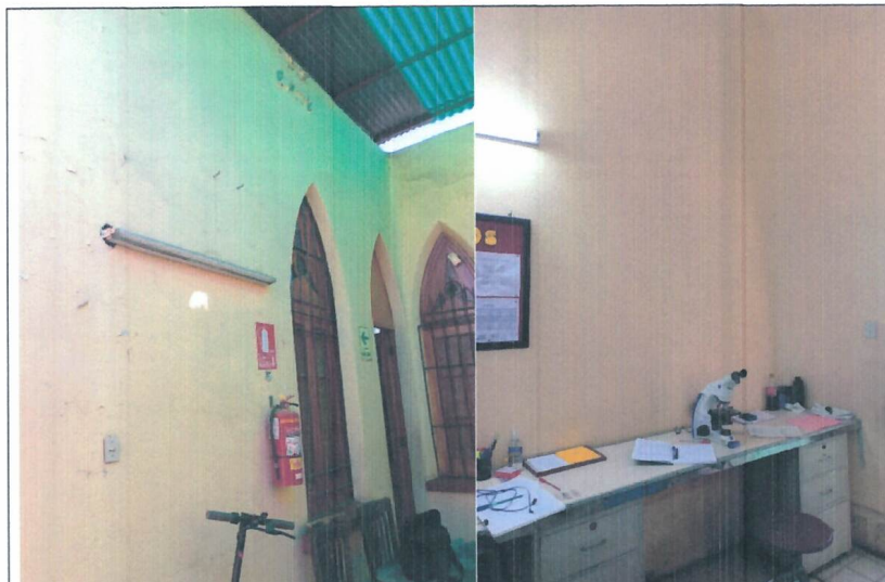
Figura 09: Patio: Pintura deteriorada por lluvia, Estructura metálica con presencia de óxido. Puertas y Ventanas de carpintería de madera deterioradas.
