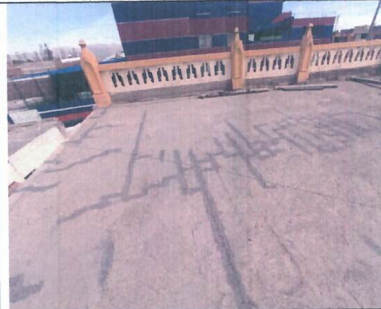
Figura 30: Impermeabilización de techos realizada con brea.
