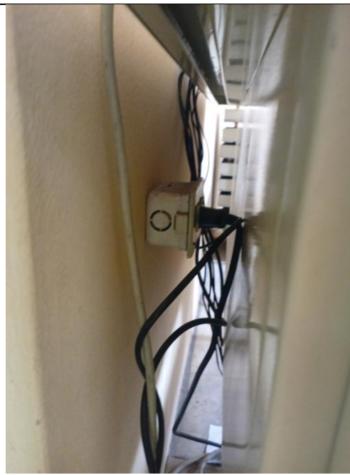
Figura 22: Citopatología 1: Caja de tomacorrientes expuesta sin empotrar a muro.
