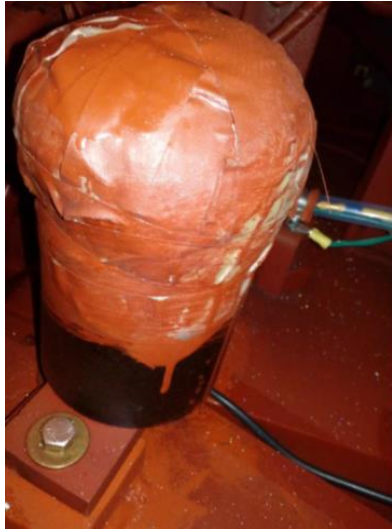
Gráfico N° 1.- Vista de los acopladores del sistema de monitoreo de descargas parciales montados en el bus del estator, así como el cable y conector a tierra.
