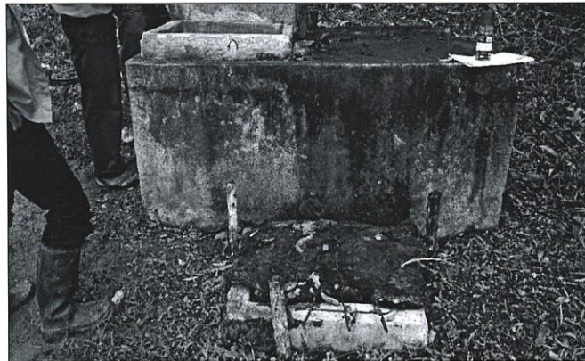
FOTO 07: Se nota que, en la parte inferior del reservorio, se encuentran sedimentos debido a que con el tiempo la tubería de la línea de conducción se ha fisurado y han ingresado sedimentos, los bordes de la tapa están fisurados.
