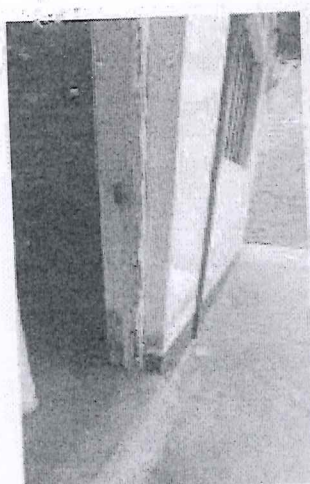
MARCO DE PUERTA DETERIORADO
