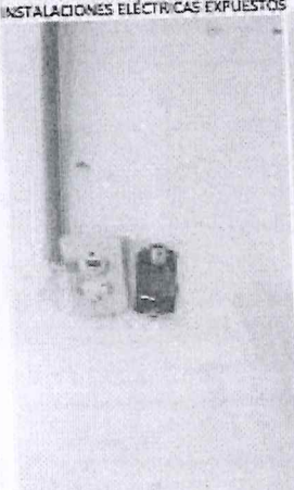
INTERRUPTOR COLAPSADO Y CABLES ELÉCTRICOS EXPUESTOS
