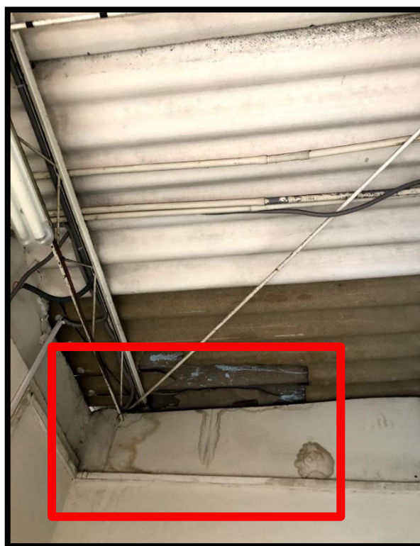
Foto N° 02: Vista de techo deteriorado por tiempo y humedad del laboratorio del 5to piso, remoción de techos.
