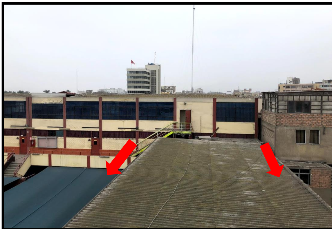
Foto N° 12: Vista de canaletas a intervenir del 5to piso, remoción de canaletas.
