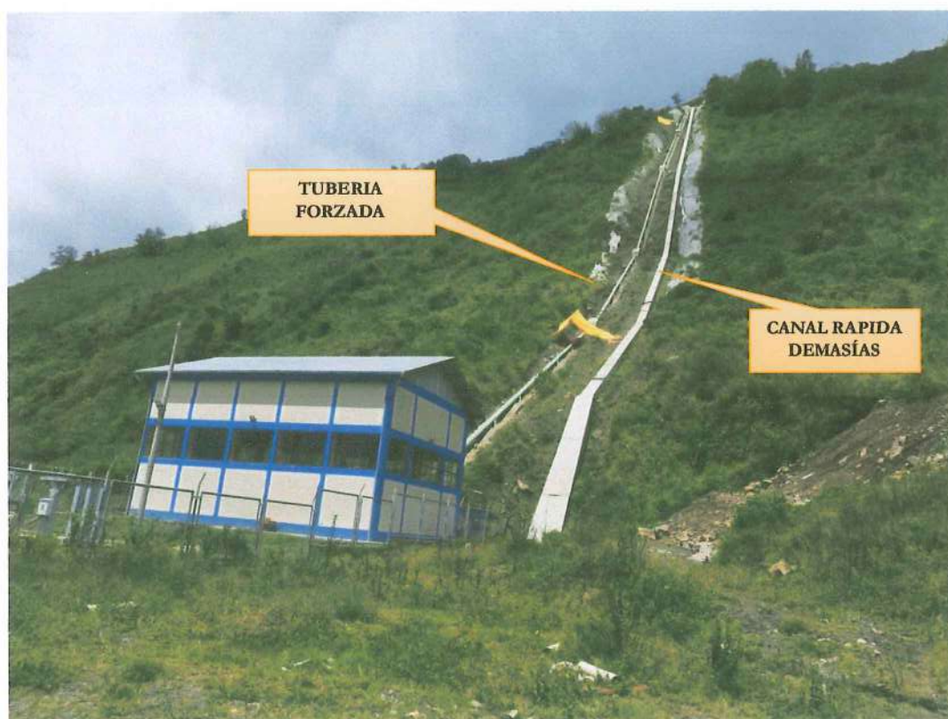
Foto 5: Vista de la Tubería Forzada
