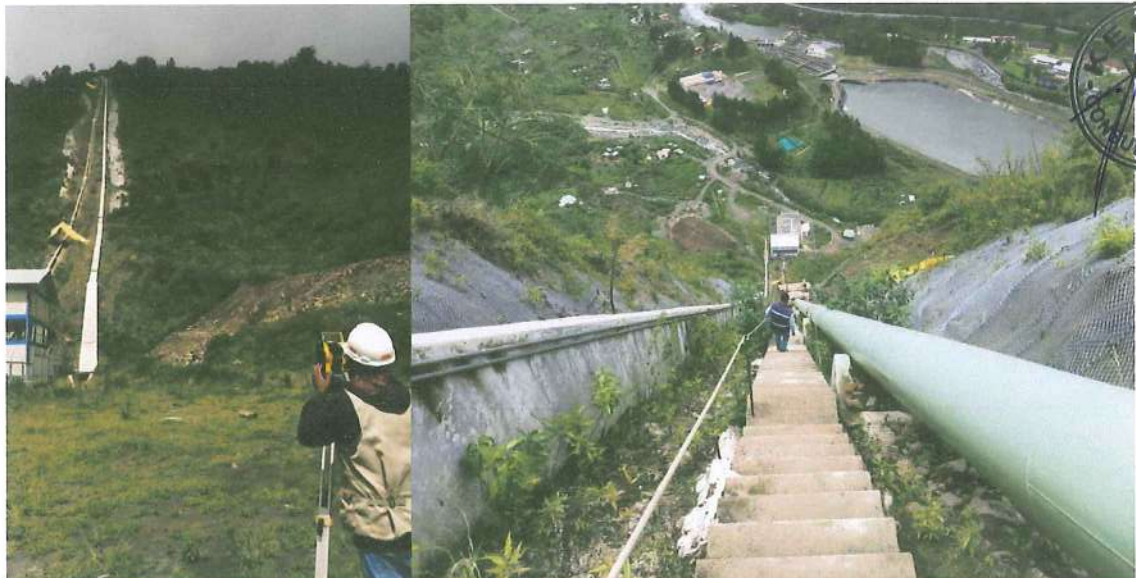
Figura 6. Tramo de la tubería forzada
