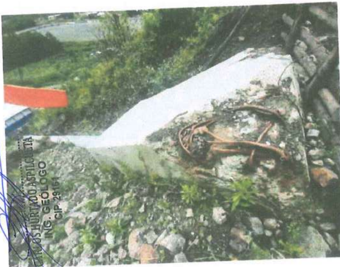
Gráfico N°: 04 Dado de concreto Dañado por las rocas de deslizamiento Acero descubierto por el golpe.
