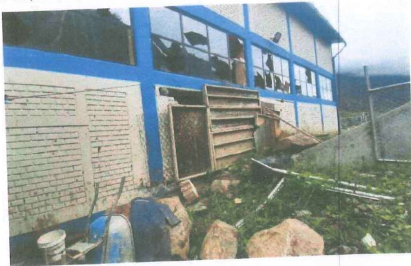
Gráfico N°:01 Cuarto de máquinas Daño ocasionado por deslizamiento de rocas.
