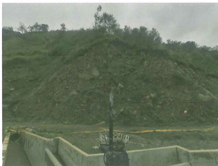
Foto 10: Talud de corte por encima de la cámara de carga.
