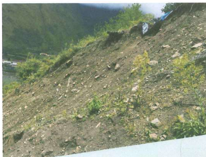
Foto 2: Inicio del deslizamiento talud derecho progresiva 0+008
