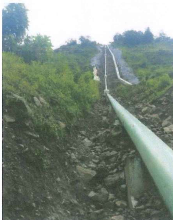
Figura 6. Zanja que aloja la tubería forzada
