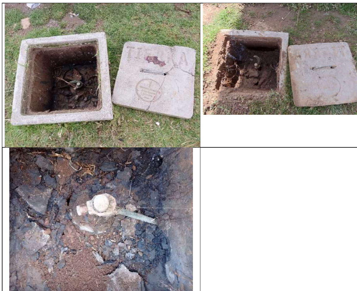
Fig. N° 42 POZOS UBICADOS ALREDEDOR DEL TAMBO, PARA CAMBIO DE CONECTOR, TAPA Y LIMPIEZA.
