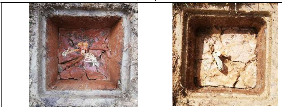
Fig. N° 34 POZOS UBICADOS ALREDEDOR DEL TAMBO, PARA CAMBIO DE CONECTOR Y LIMPIEZA.
