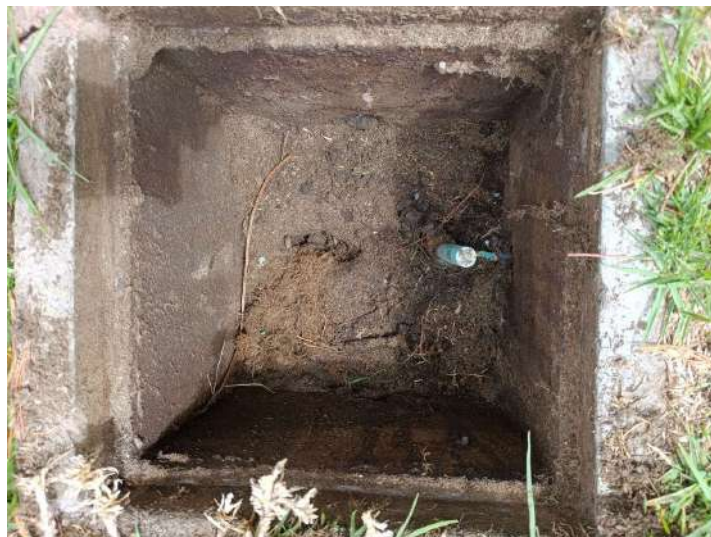
Fig. N° 07 UBICADO EN LA PARTE POSTERIOR, COSTADO IZQUIERDO, PRESENTA CAJA DE CONCENTRO SIN PINTAR, CABLE EN MUY MAL ESTADO (Pozo a intervenir)
