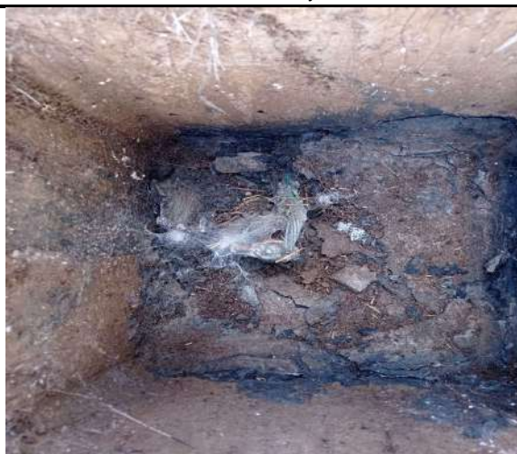
Fig. N° 41 UBICADO EN LA PARTE DELANTERA, COSTADO IZQUIERDO, PRESENTA CAJA DE CONCRETO DETERIORADO (pozo a intervenir).
