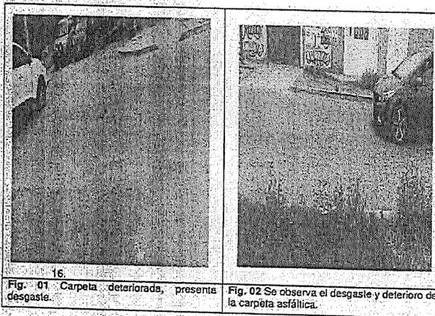
Fig. 01 - Carpeta deteriorada, presenta desgaste.
