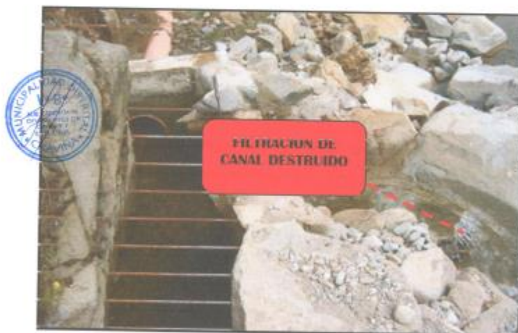
Sistema de riego destruido.
