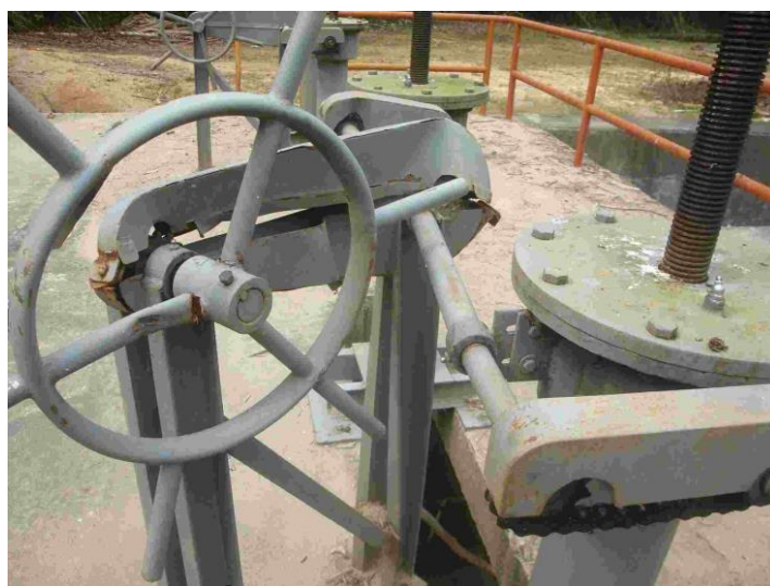
FOTOGRAFÍA 4. Mecanismo de izaje y tornillo Averiado.
