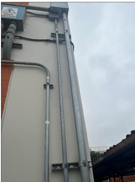
Montante de señal de DACI y Montante Eléctrica
