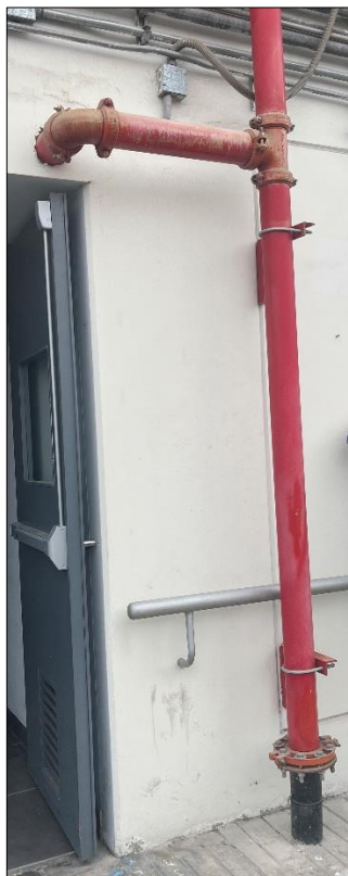
Montante de tubería de Agua contra incendio
