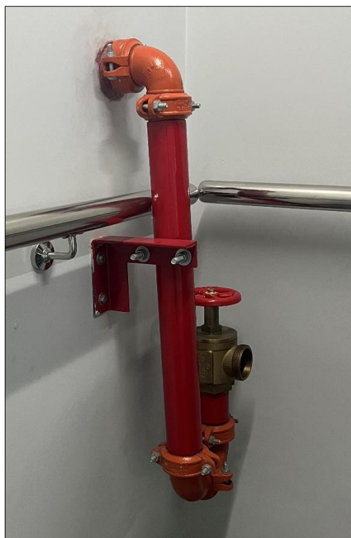
Mantenimiento de la Válvula de conexión.
