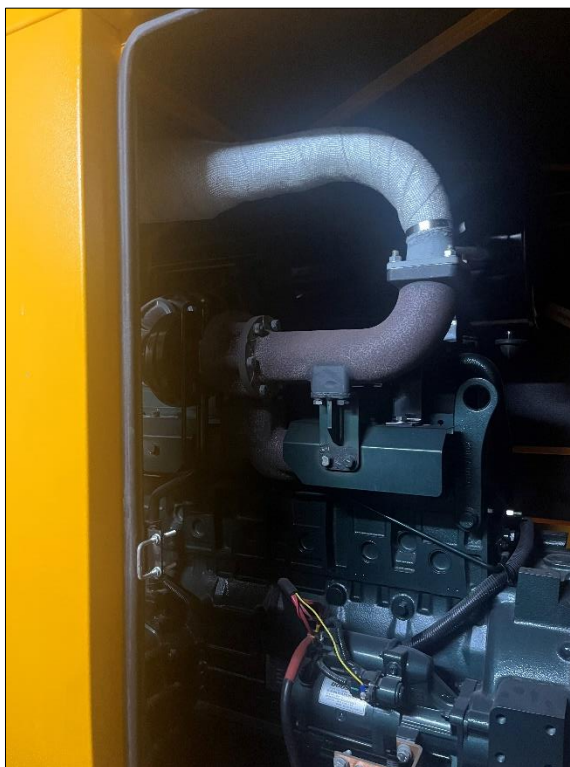
Motor Primo del Generador eléctrico – Ubicado en el cuarto de bombas
