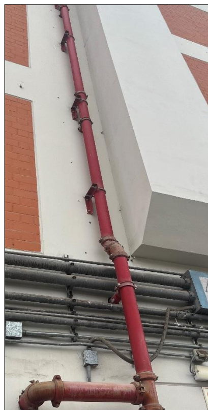
Montante de tubería de Agua contra incendio
