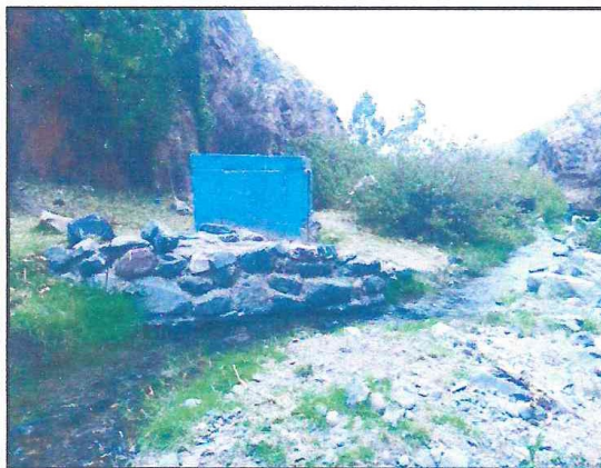
Imagen N°01. Captación construida de manera rústica.
