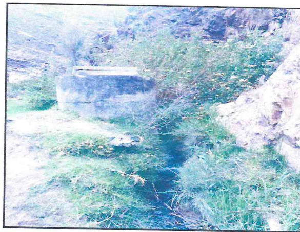
Imagen N°02. Caja de inspección con una antigüedad de 30 años, se observa el canal de conducción de terreno natural, afectado por malezas.
