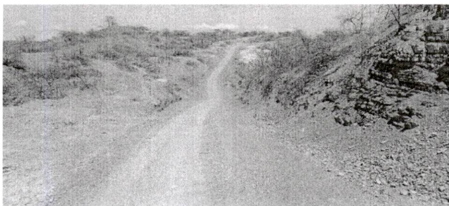
VÍA EXISTENTE CON AHUELLAMIENTO
