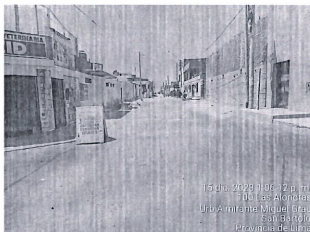
FOTO 13.- Se puede apreciar un pavimento con exceso de fino
