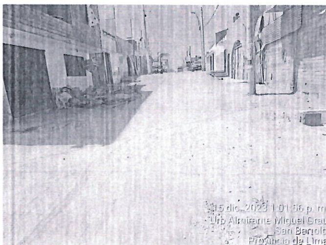
FOTO 10.- Se puede apreciar pavimento a nivel de afirmado
