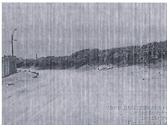
FOTO 02.- Se aprecia se apreciar que la capa de afirmado ha perdido el fino.
