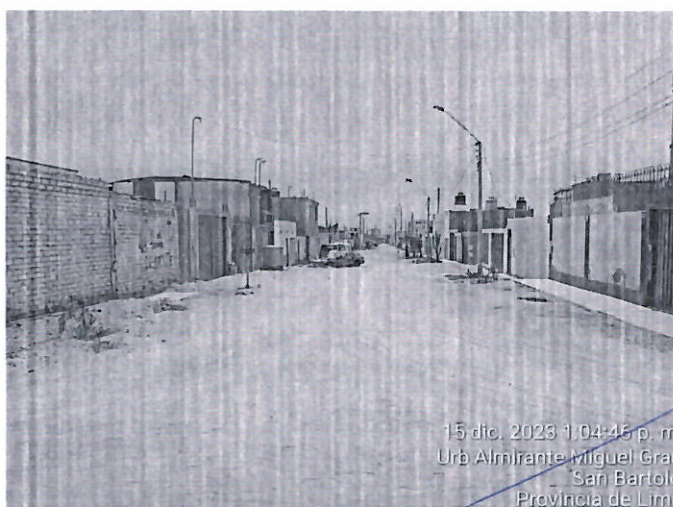
FOTO 11.- Se puede apreciar pavimento a nivel de afirmado
