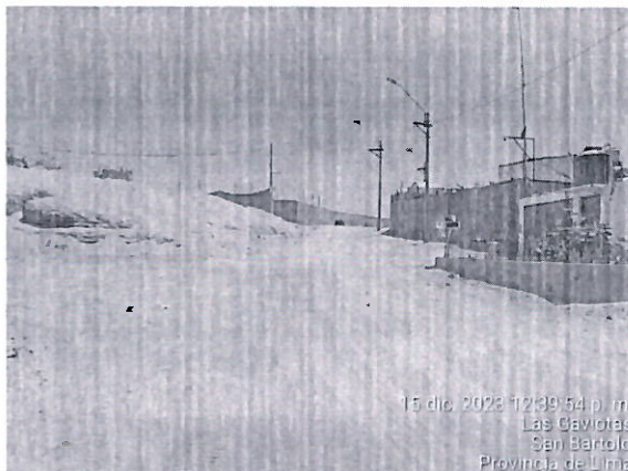
FOTO 01.- Se aprecia se apreciar que la capa de afirmado ha perdido el fino.
