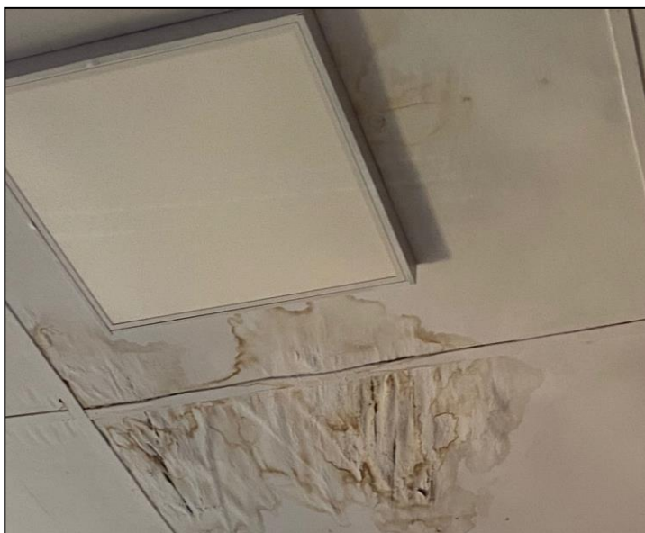
IMAGEN 5. FALSO CIELO RASO DE TRIPLAY AFECTADO POR LA HUMEDAD.
