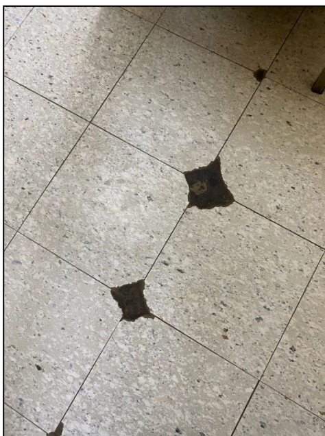
IMAGEN 1. PISO DEL BLOQUE DE LA DIRECCIÓN DE ESTUDIOS REVESTIDA DE BALDOSAS DE VINIL EN MAL ESTADO
