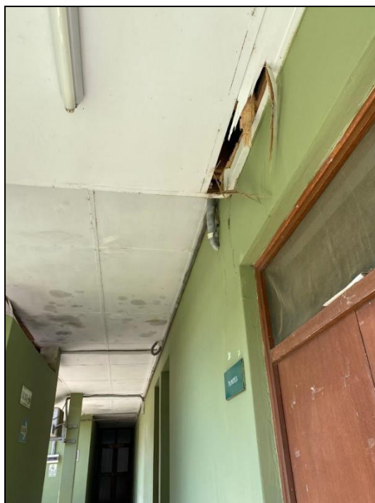
IMAGEN 4. FALSO CIELO RASO DE TRIPLAY EN MAL ESTADO.
