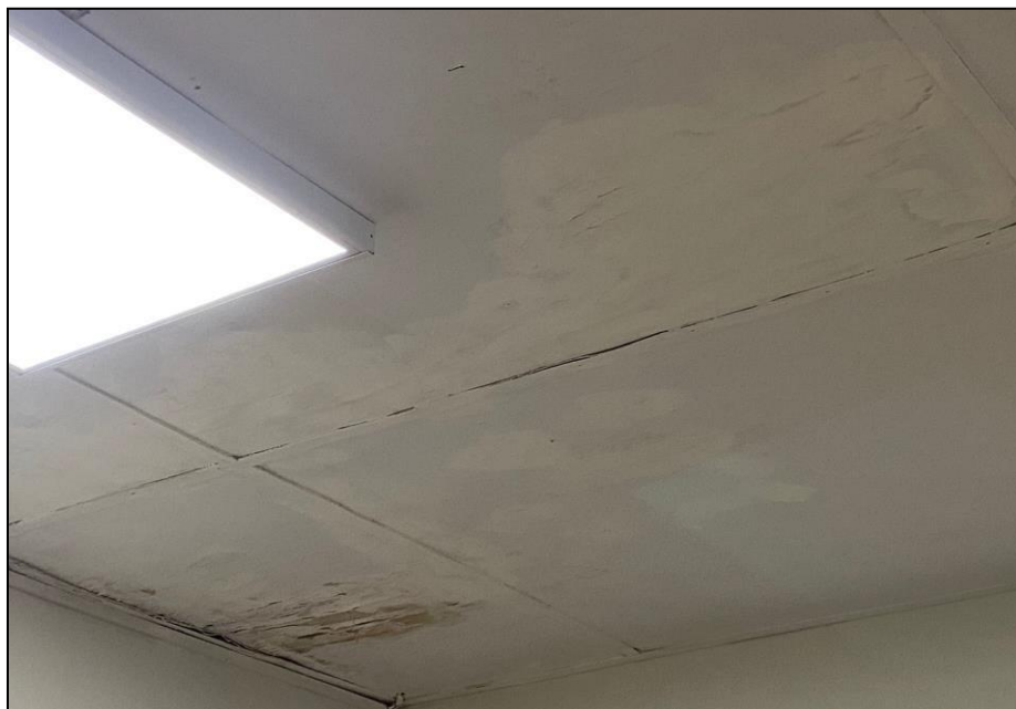
IMAGEN 6. FALSO CIELO RASO DE TRIPLAY AFECTADO POR LA HUMEDAD. 1
