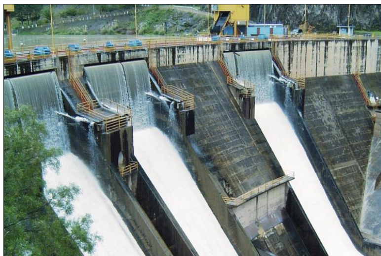
Figura 5 Vertederos, juntas y barandas aguas abajo de la Presa Tablachaca
