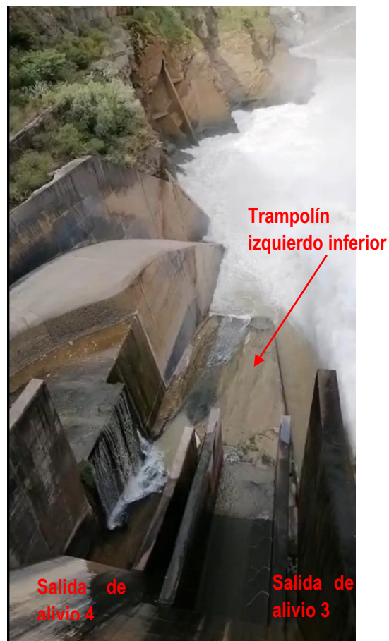
Figura 7 Salida del Alivio 4 y 3, aguas abajo de la Presa Tablachaca
