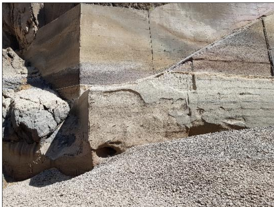
Foto 8 Daños en Trampolín Derecho vista desde aguas abajo
