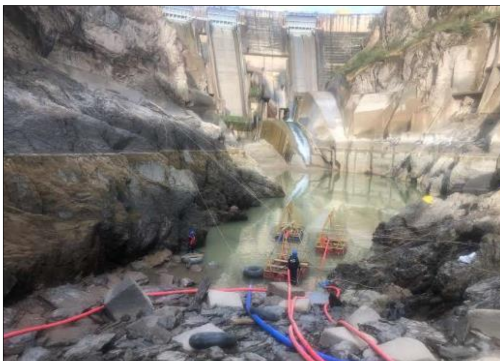
Foto 2 Trabajos de Bombeo de Poza de Disipación vista desde aguas abajo
