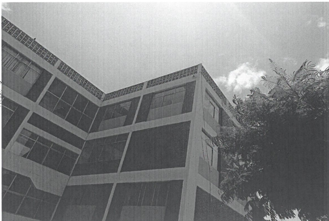
FOTO N° 04 PARTE EXTERIOR DE LA ESCUELA DE POSGRADO SE OBSERVA QUE NO CUENTA CON CANALETAS NI MONTANTES PARA LA BAJADA DE LAS AGUAS DE LLUVIAS
