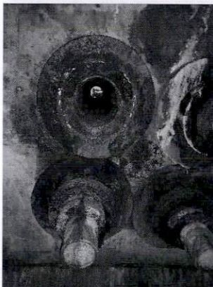
Ductos y socket de la cámara de anclaje
