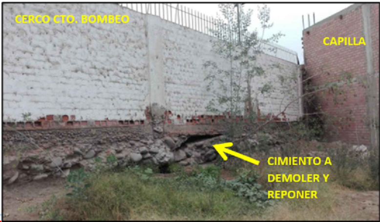
*ACONDICIONAMIENTO DE CIMIENTO EN CERCO PERIMETRICO DE CTO. DE BOMBEO EN CAPILLA-EXTERIOR AL EP.
