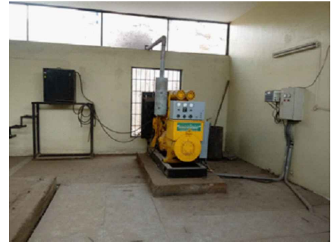
GRUPO ELECTROGENO (SALIPOS) - MANTENIMIENTO PREVENTIVO DE GRUPO ELECTROGENO (Abierto, 200kW Prime, Trifásico, 60Hz), incluye tablero - MANTENIMIENTO PREVENTIVO TABLERO CARGADOR DE BATERIA - MANTENIMIENTO PREVENTIVO POZO DE TIERRA
