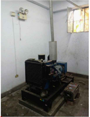
GRUPO ELECTROGENO (CLINICA) - MANTENIMIENTO PREVENTIVO DE GRUPO ELECTROGENO (Abierto, 30kW Prime, 220V, Trifasico, 60Hz) - MANTENIMIENTO PREVENTIVO TABLEROS DE FUERZA 220V,Trifasico, 60Hz - MANTENIMIENTO PREVENTIVO TABLERO DE TRANSFERENCIA MANUAL
