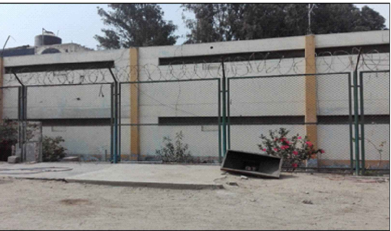
*ACONDICIONAMIENTO DE CERCO METÁLICO TIPO 1- COLINDANTE PABELLÓN N°20, SUMINISTRO DE CONCERTINA; MANTENIMIENTO CON PINTURA *DESMONTAJE PARCIAL DE CERCO METÁLICO TIPO 1- COLINDANTE PABELLÓN N°20, Y DESMONTAJE DE CONCERTINA.
