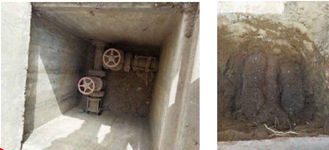
MEJORAMIENTO DE LINEA DE IMPULSION DE LA CISTERNA HACIA EL RESERVORIO ELEVADO EN ZONA LLAMADA "LA ARROCERA" - DEMOLICION DE PISO DE CONCRETO. - CAMBIO DE TUBERIA DE DN75MM PVC-UF EN LINEA DE IMPULSION DE AGUA. - REPOSICION DE PISO DE CONCRETO.
