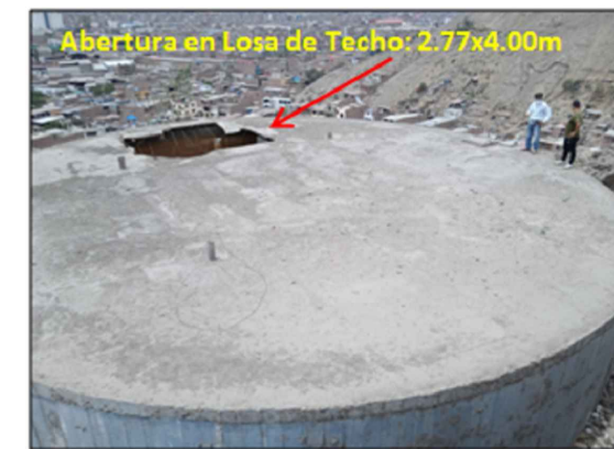
*ACONDICIONAMIENTO DE TECHO EN RESERVORIO APOYADO DE AGUA, EN LADERA DE CERRO EN INTERIOR AL EP.
