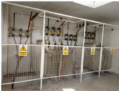
SUBESTACION ELECTRICA PRINCIPAL - MANTENIMIENTO PREVENTIVO CELDA DE LLEGADA EN MT - MANTENIMIENTO PREVENTIVO CELDA DE TRANSFORMACION (400kVA, 10/0.23kV) - MANTENIMIENTO PREVENTIVO POZO DE TIERRA
