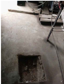
MANTENIMIENTO PREVENTIVO POZO DE TIERRA - MANTENIMIENTO PREVENTIVO POZO DE TIERRA (CUARTO GE, CASETA DE BOMBEO AGUA "LA CAPILLA")
