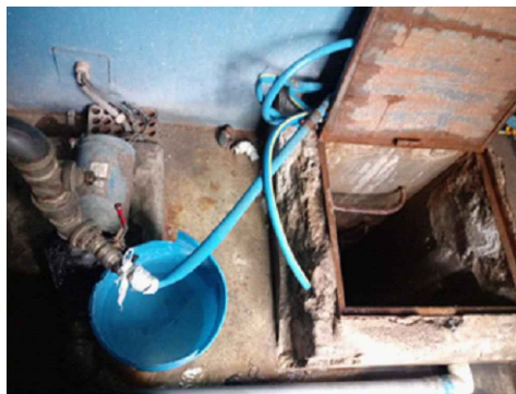
MANTENIMIENTO PREVENTIVO ELECTROBOMBAS - ELECTROBOMBA HORIZONTAL 3.5HP, 220V, TRIFASICO, 60Hz (PABELLON - 08) - ELECTROBOMBA HORIZONTAL 3.5HP, 220V, TRIFASICO, 60Hz (PABELLON - 11A)
