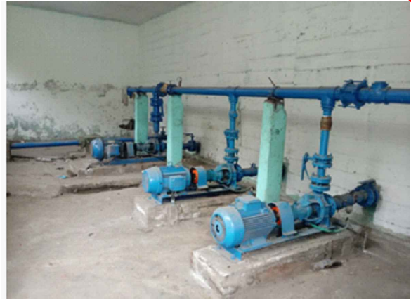
CASETA DE REBOMBEO - SUMINISTRO E INSTALACION DE VALVULA MARIPOSA TIPO WAFER DE 6" INCLUYE DESMONTAJE DE LA VALVULA DEFECTUOSA. - LIMPIEZA Y DESINFECCION DE CISTERNA.
