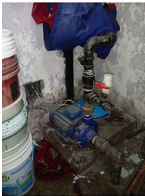
MANTENIMIENTO PREVENTIVO ELECTROBOMBAS - ELECTROBOMBA HORIZONTAL 1.5HP, 220V, TRIFASICO, 60Hz (AREA PSICOLOGIA)
