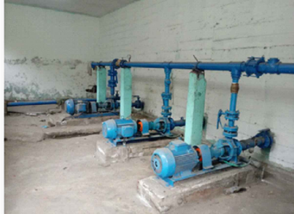
MANTENIMIENTO CORRECTIVO BOMBAS - BOMBA HORIZONTAL 32 HP,380/220V,TRIFASICO,60HZ ( BOMBEO DE AGUA DE CONSUMO A RESERVORIO)
