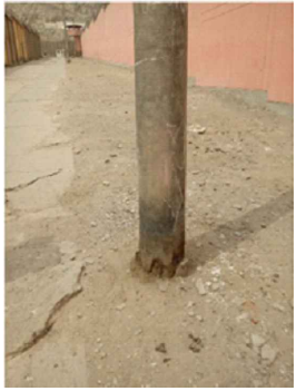
POSTES PERIMETRALES DE CONCRETO C/PASTORALES DOBLES Y SIMPLES (LUMINARIAS Na 400W)- TIERRA DE NADIE - REPOSICION DE LAMPARAS NA 400W EN LUMINARIAS EXISTENTES APAGADAS - REPOSICION DE LUMINARIAS CON LAMPARAS NA 400W - REFUERZO DE BASE DE POSTES DE CONCRETO ( ZOCALOS)
