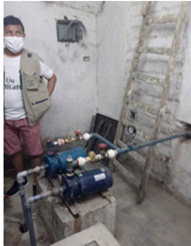
MANTENIMIENTO PREVENTIVO ELECTROBOMBAS - ELECTROBOMBA HORIZONTAL 1.5HP, 220V, TRIFASICO, 60Hz (AREA PSICOLOGIA)
