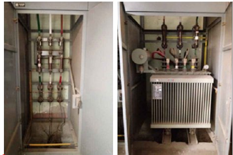
CUARTO ELECTRICO BAJA TENSION (SALIPOS) - MANTENIMIENTO PREVENTIVO TABLERO GENERAL 3 CUERPOS AUTOPORTADO, 220V, Trif, 60Hz. (TG, TG-T1, TG-T2) - MANTENIMIENTO PREVENTIVO TABLERO TRANSFERENCIA (TT) - MANTENIMIENTO PREVENTIVO POZO DE TIERRA
