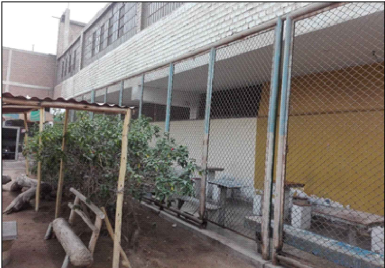
*ACONDICIONAMIENTO DE CERCO METÁLICO TIPO 2- COLINDANTE PABELLÓN N°20; SUMINISTRO E INSTALACION DE CONCERTINAS *DESMONTAJE PARCIAL DE CERCO METÁLICO TIPO 2- COLINDANTE PABELLÓN N°20. *ACONDICIONAMIENTO DE BASE DE PARANTE CERCO TIPO 1 Y2
