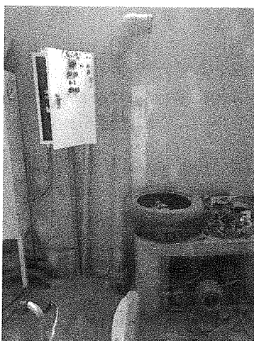
Foto N°1: tubería de PVC y válvula de pie con canastilla de succión de 4 pulgadas existente ubicado en la caseta de bombeo "La Capilla"
