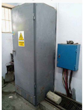
GRUPO ELECTROGENO (CLINICA) - MANTENIMIENTO PREVENTIVO DE GRUPO ELECTROGENO (Abierto, 30kW Prime, 220V, Trifasico, 60Hz) - MANTENIMIENTO PREVENTIVO TABLEROS DE FUERZA 220V,Trifasico, 60Hz - MANTENIMIENTO PREVENTIVO TABLERO DE TRANSFERENCIA MANUAL
