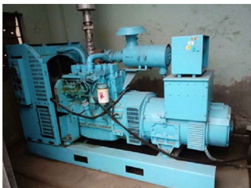
GRUPO ELECTROGENO - MANTENIMIENTO PREVENTIVO DE GRUPO ELECTROGENO: Abierto, 275kW Prime, 220V, Trifásico, 60Hz
