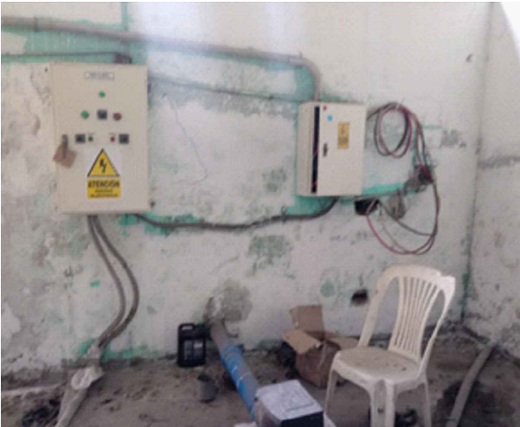
MANTENIMIENTO CORRECTIVO TABLEROS ELECTRICOS - TABLERO DE DISTRIBUCION 220V,TRIFASICO, 60HZ (PABELLON -11A)
