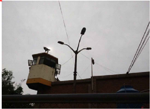
TORREONES DE VIGILANCIA - REPOSICION REFLECTOR BUSCA PERSONAS: 400W, VAPOR NA, SIMILAR MODELO C-51
