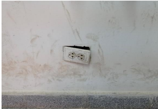
Fotografía N°01: Interruptores y Tomacorrientes en mal estado – Aulas, talleres y laboratorios
