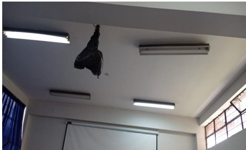
Fotografía N°02: Fluorescentes en mal estado y sin funcionamiento - Aulas, talleres, laboratorios
