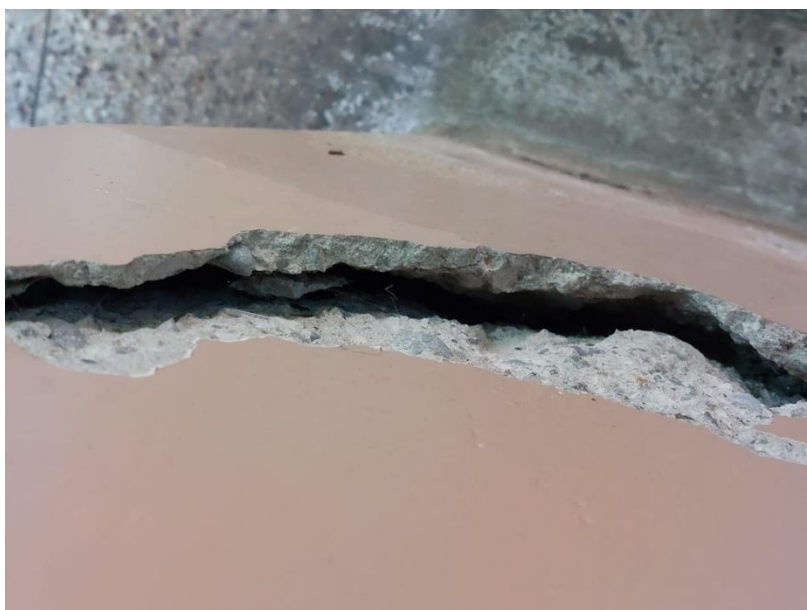
Fig. 14. – Fisuramiento en columna
