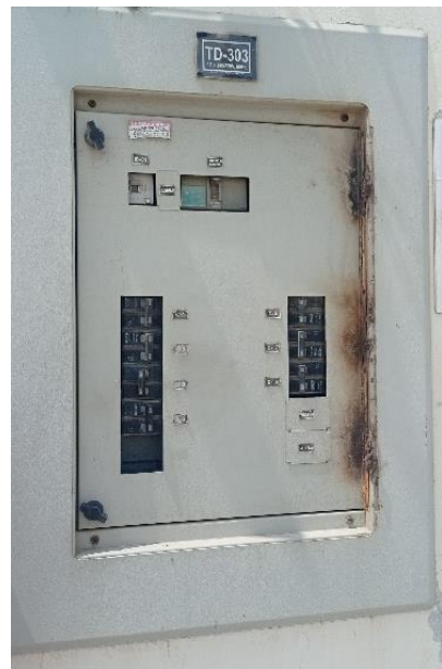
Fotografía N°18: Tableros eléctricos sin mantenimiento.
