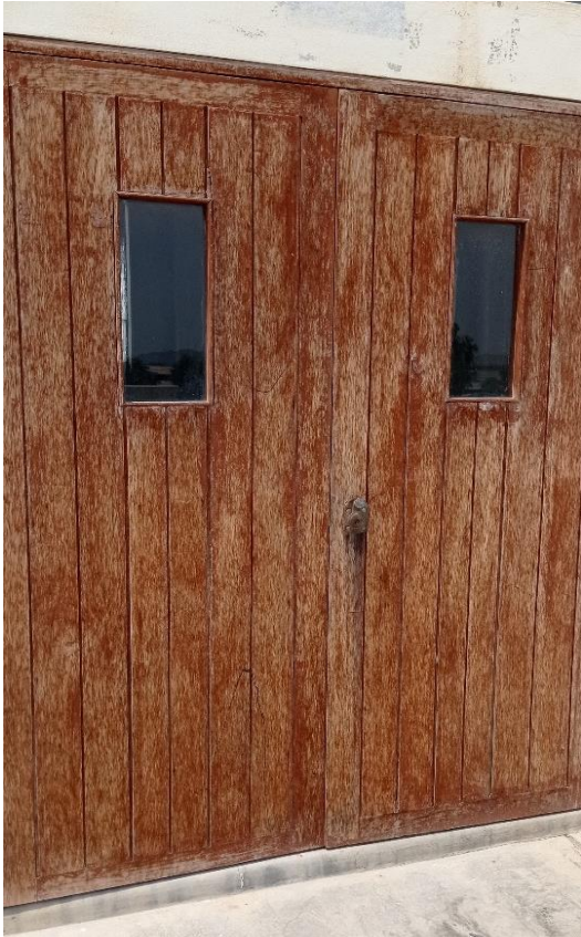
Fotografía N°15: Puertas de aulas del 3° Piso, deterioradas por el tiempo y el sol.
