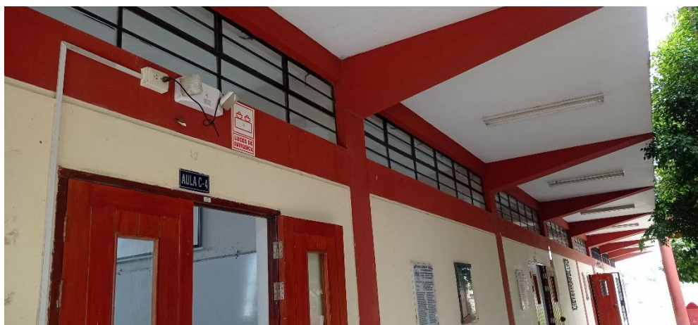
Fotografía N°03: Luces de Emergencia sin funcionamiento.
