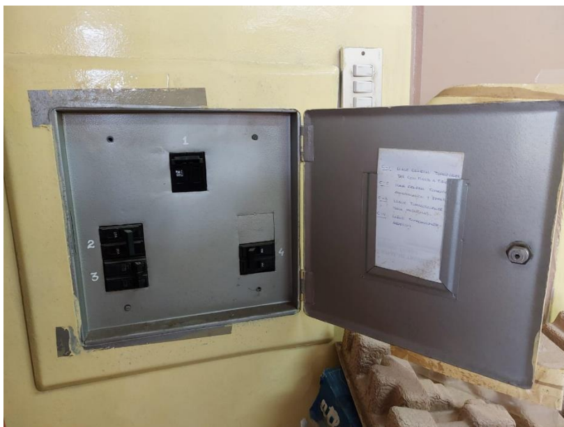
Fig. 13. – Tableros Eléctricos en mal estado y en deshuso
