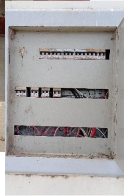
Fotografía N°10: Tableros eléctricos sin mantenimiento.
