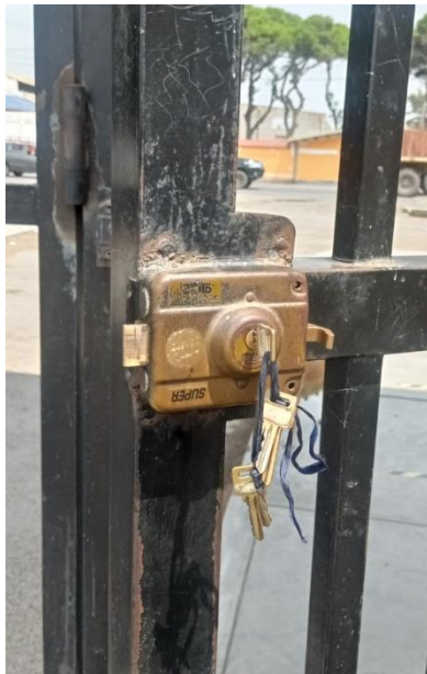
Fotografía N°23: Cerradura de sobreponer de mal funcionamiento.
