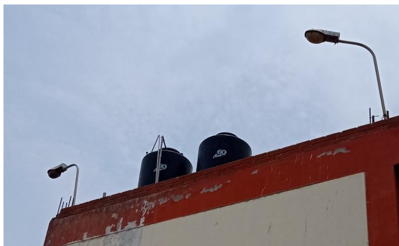
Fotografía N°09: falta de mantenimiento y deterioramiento de los tanques elevados Y postes de luz sin funcionamiento.
