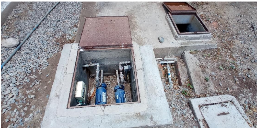
Fotografía N°08: falta de mantenimiento en cisterna y cuarto de bombas.
