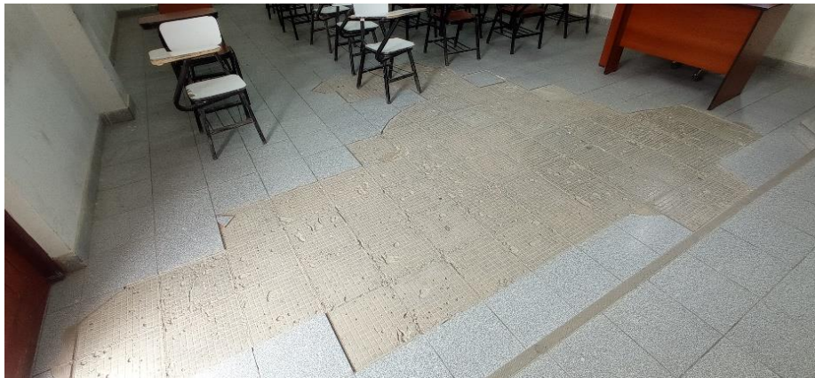
Fotografía N°11: Pisos de cerámica en aulas en mal estado.
