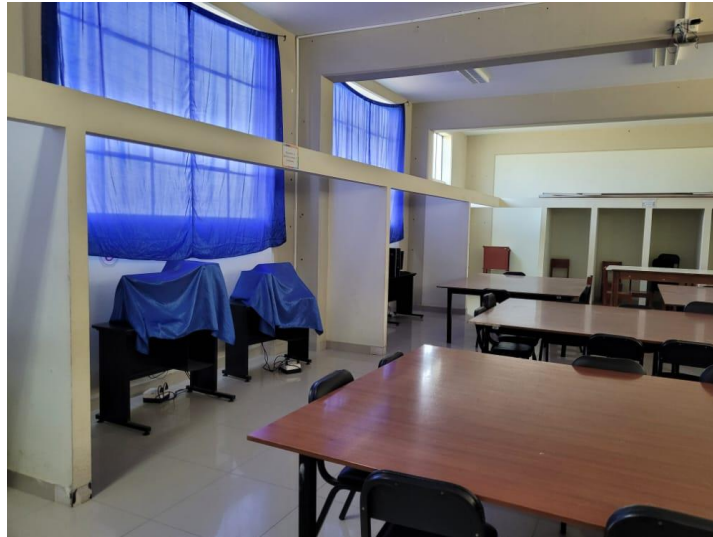
Fotografía N°19: Muros de Drywall en mal estado, se realizara su desmontaje.
