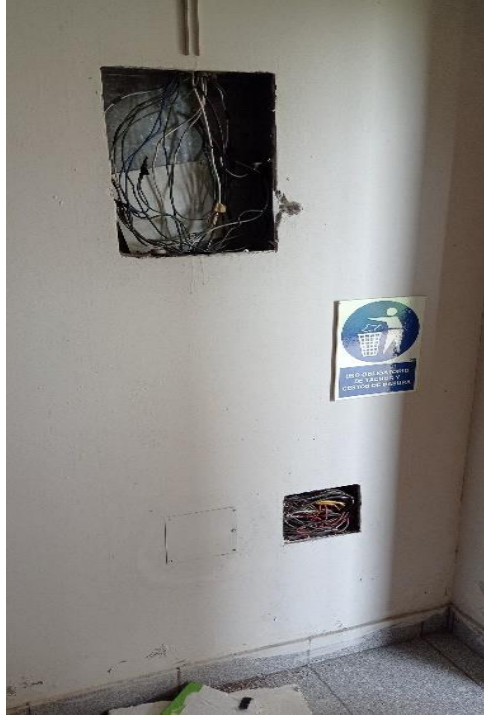
Fotografía N°10: Tableros eléctricos sin mantenimiento.
