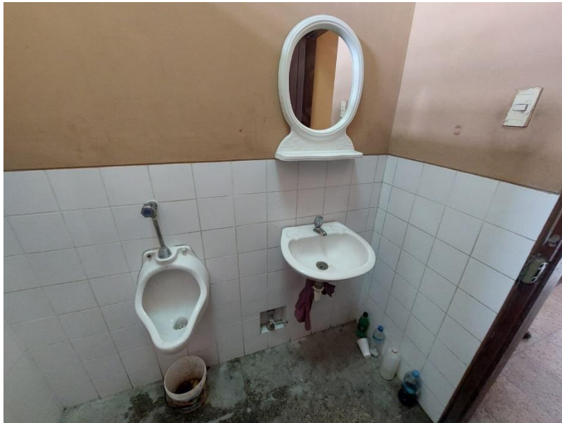
Fig. 11. – Urinarios en pésimo estado, filtraciones y falta de limpieza en SSHH
