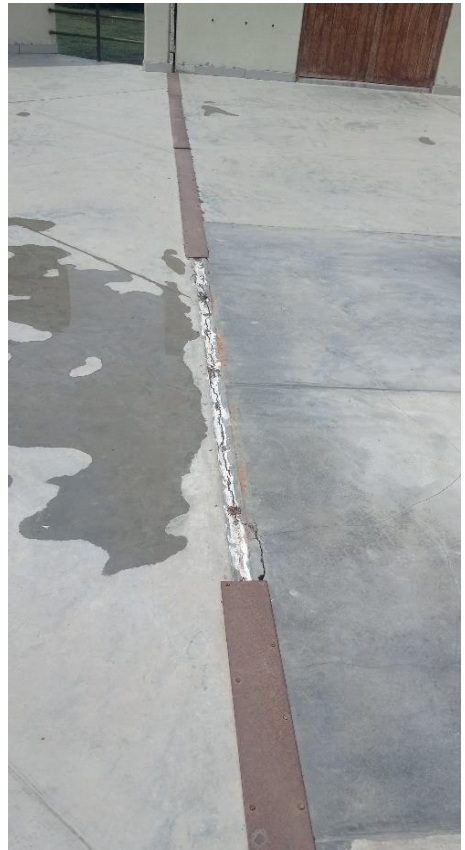
Fotografía N°16: Tapas juntas metálicas oxidadas y en mal estado.
