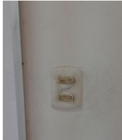
Fotografía N°01: Interruptores y Tomacorrientes en mal estado – Aulas, talleres y laboratorios
