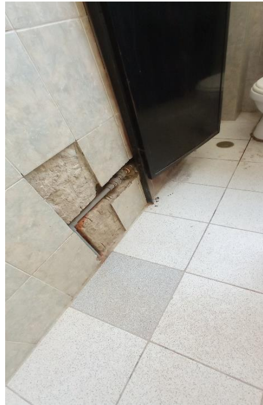
Fotografía N°05: Baños sin caja de paso y llaves Deterioraras.
