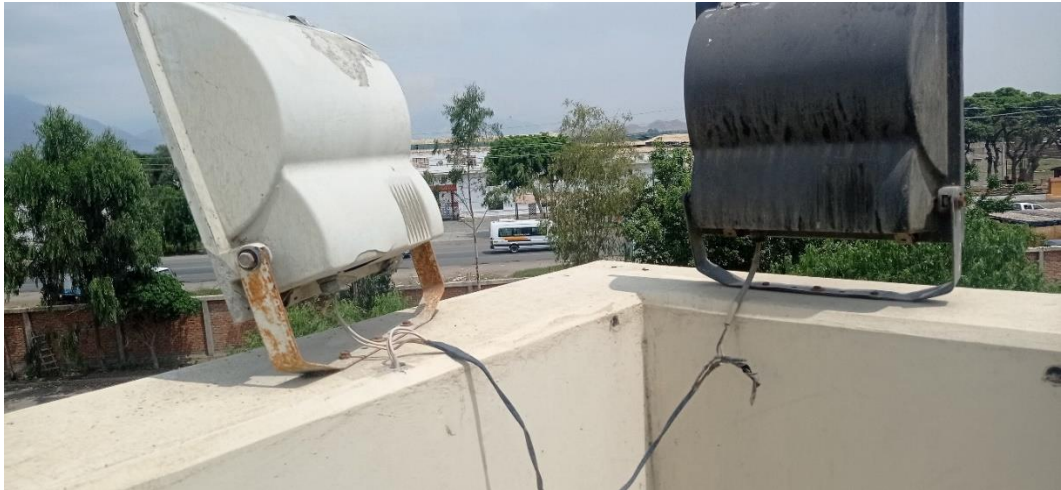
Fotografía N°13: Reflectores de iluminación sin funcionamiento
