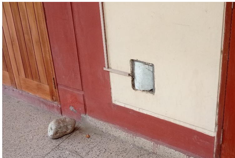
Fotografía N°06: Cajas de paso eléctricas sin tapas.
