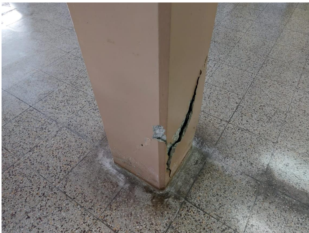
Fig. 01. – Columna en mal estado, presenta fisuras y falta de mantenimiento
