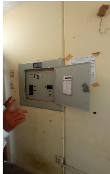
Fotografía N°24: Tableros eléctrico sin mantenimiento en caseta de vigilancia.
