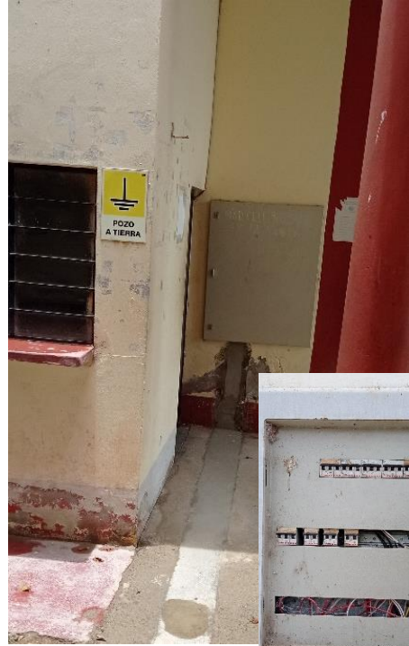
Fotografía N°10: Tableros eléctricos sin mantenimiento.
