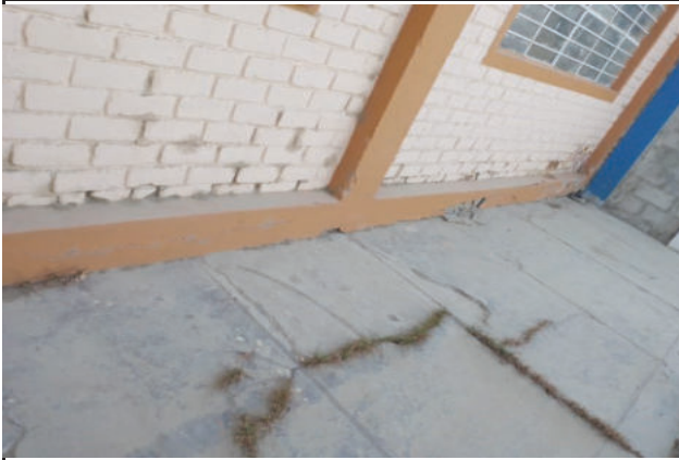
Vista de veredas, se observa grietas, dichas fallas se repiten en pisos y patios de cemento pulido
