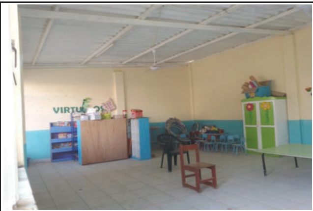
Vista interior de aula, se observa cobertura liviana, columnas no alcanzan toda la altura del muro.
