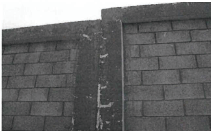
Foto N° 04: Vista de fisuras de elementos estructurales en columna
