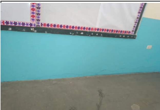
Vista de aula, se observa fisura en el muro cercana al piso
