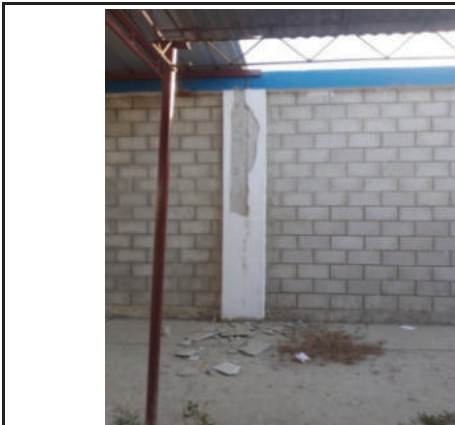
Vista de columna en el cerco perimetrico, perdida de enlucido, inadecuada junta de dilatacion
