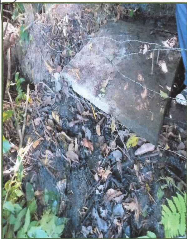
Vista N°03: En esta imagen se puede la tapa de concreto afectado producto del FEN Costero.
