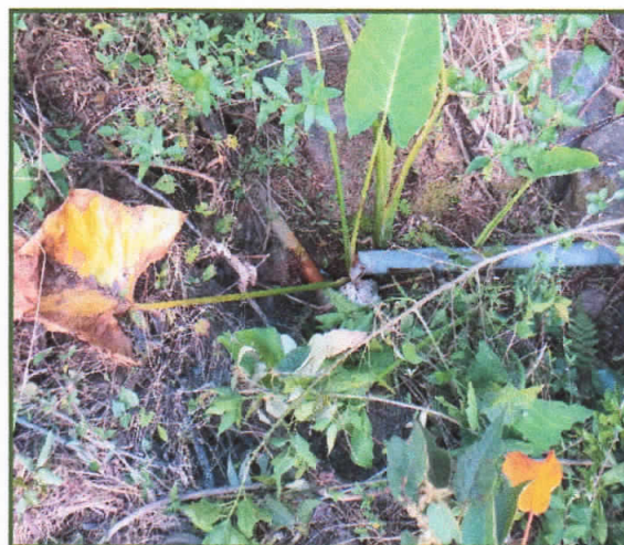
Vista N°10: En esta imagen se puede apreciar tubería PVC de 3/4"expuesta en mal estado afectado producto del FEN Costero
