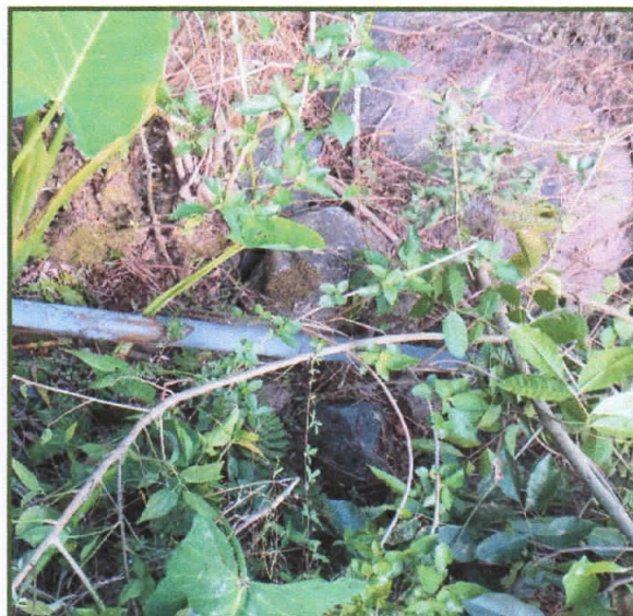
Vista N°12: En esta imagen se puede apreciar tubería PVC de 3/4"expuesta en mal estado afectado producto del FEN Costero
