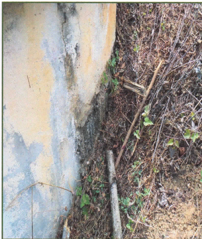
Vista N°27: En la imagen se aprecia filtraciones de agua en la base del reservorio, producto del FEN Costero
