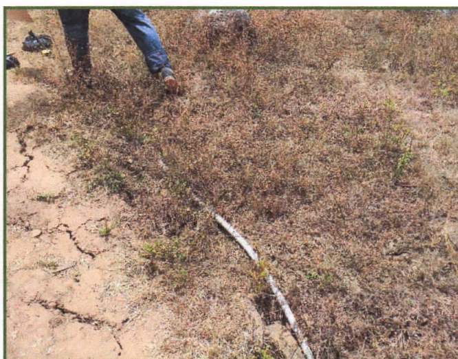
Vista N°35: En la imagen se aprecia tubería PVC de 3/4" expuesta. afectado producto del FEN Costero.
