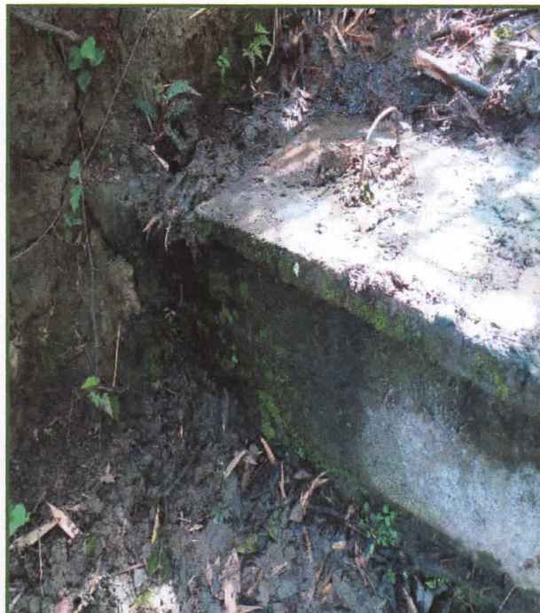
Vista N°06: En esta imagen se puede apreciar estructura de captación en mal estado afectado producto del FEN Costero
