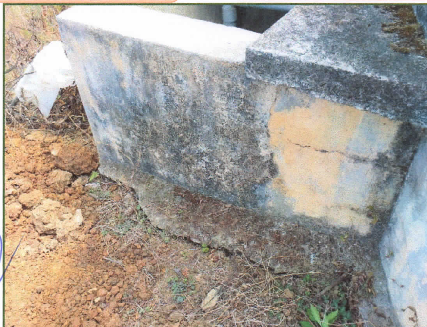
Vista N°26: En la imagen se aprecia al reservorio con fisuras, producto de las intensas lluvias del FEN Costero
