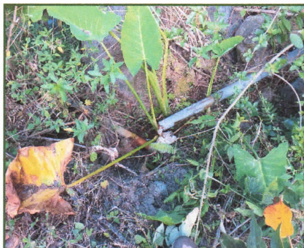
Vista N°09: En esta imagen se puede apreciar tubería PVC de 3/4"expuesta en mal estado afectado producto del FEN Costero
