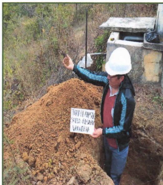
Vista N°25: En la imagen se aprecia la excavación de la calicata para la rehabilitación del reservorio en mal estado, producto de las intensas lluvias del FEN Costero
