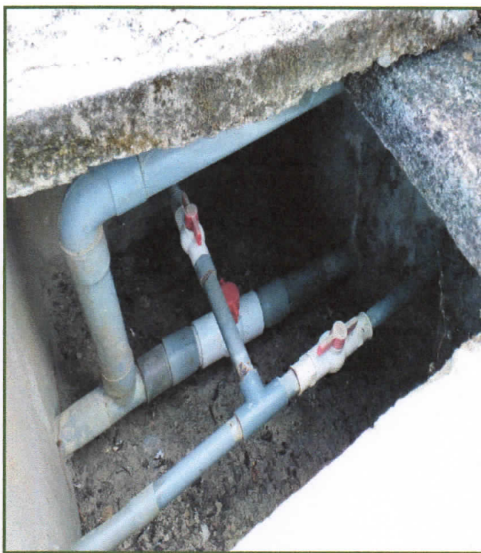
Vista N°23: En la imagen se aprecia, accesorios de la caja de válvulas, en mal estado.
