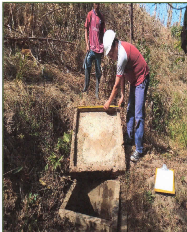
Vista N°16: En esta imagen se puede apreciar tapa de concreto en mal estado
