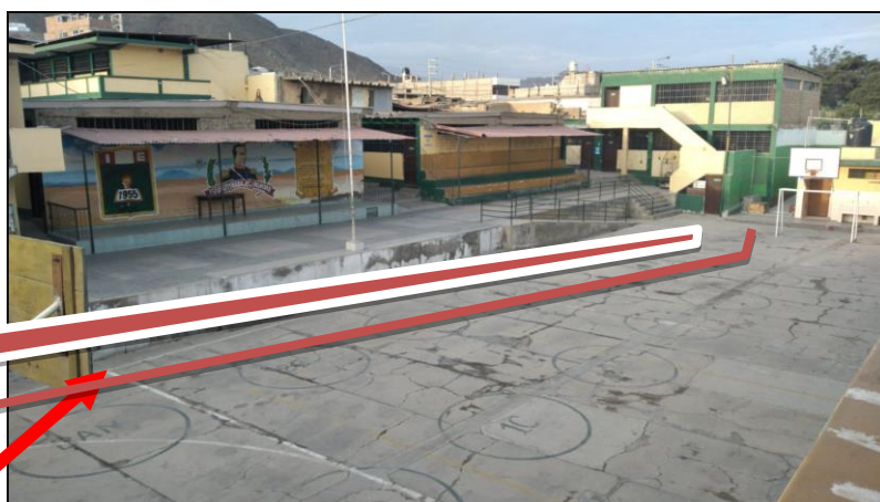
FOTOGRAFÍA: Se aprecia un gráfico por donde está el canal existente, está cubierto su techo con loza maciza de concreto armado que sirve de pasadizo de circulación, no se presenta mayores detalles porque todo está cubierto de concreto. Tiene una longitud total de 45.30m
