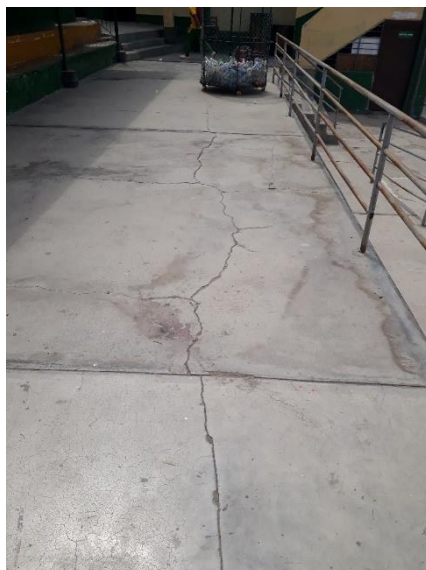
FOTOGRAFÍA: Se aprecia el canal existente, está cubierto su techo con loza maciza de concreto armado, presentando fisuras.
