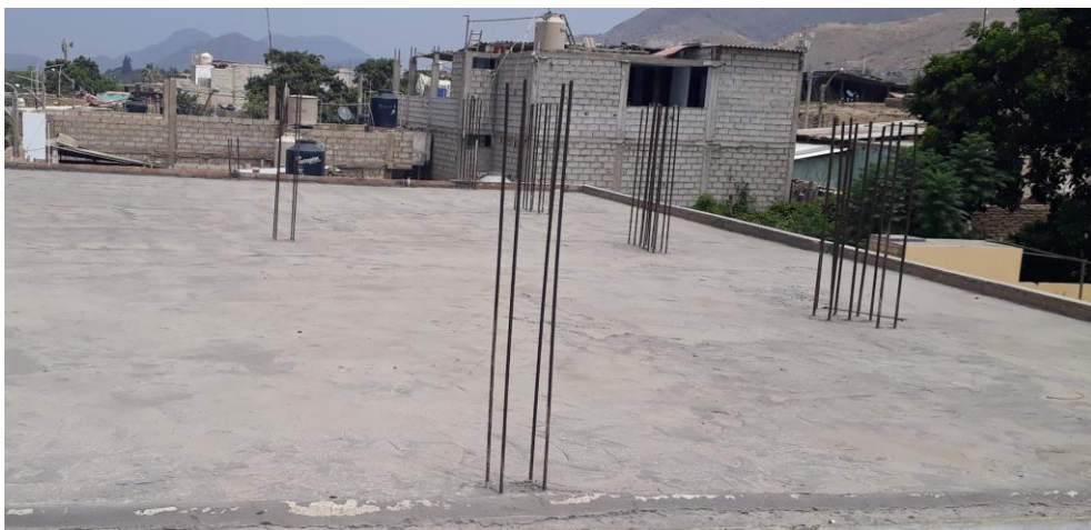
FOTOGRAFÍA: Vista de losa del bloque J, presenta fisuras en la losa, además que no cuenta con evacuación del agua de lluvias que se presentan.
