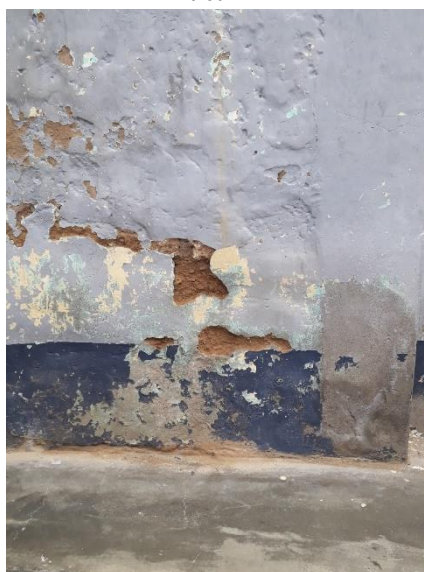
FOTOGRAFÍA: Se aprecia las consecuencias de la humedad producida en bloques aledaños al canal PRIMER NIVEL EVACUACION
