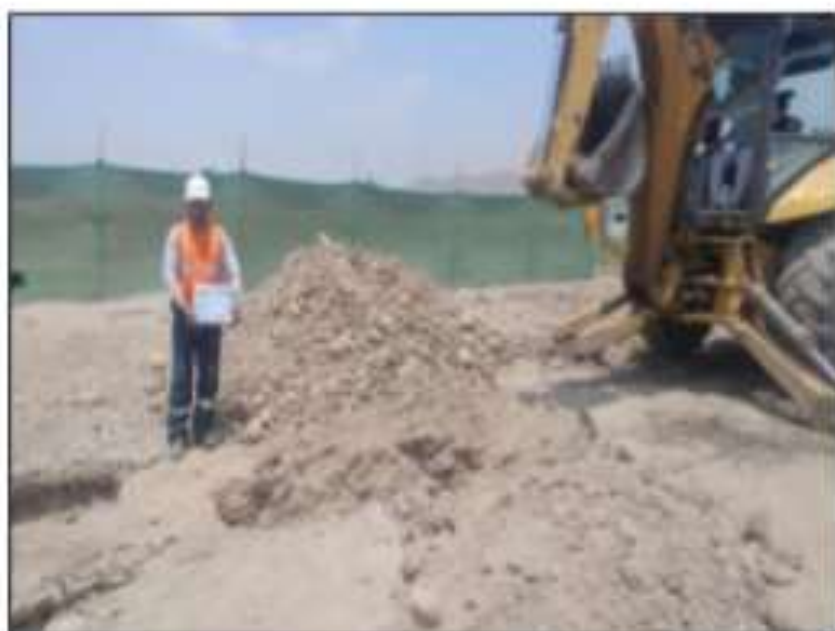
FOTO 17 Y 18 EN LAS VISTAS MOSTRADAS SE OBSERVA LA UBICACION DE LA CALICATA P-5, CONFORMADO POR SUELO LIMOSO LIGERAMENTE ARCILLOSO CON GRAVAS AISLADAS. SEMICOMPACTO, SUBYACIENDO SUELO GRAVOSO POBREMENTE GRADUADA, CON BOLONERIA DE TAMAÑO MAXIMO DE 18", EN ESTADO SEMICOMPACTO.
