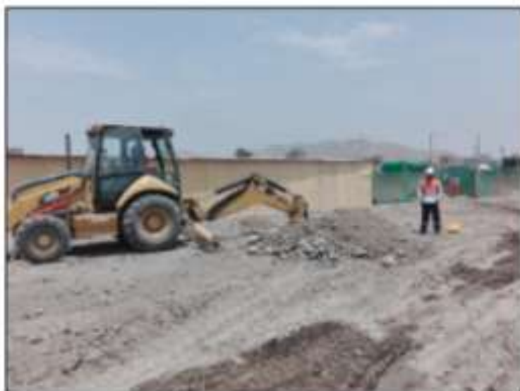
FOTO 13 Y 14 EN LAS VISTAS MOSTRADAS SE OBSERVA LA UBICACION DE LA CALICATA P-1, CONFORMADO POR SUELO LIMOSO LIGERAMENTE ARCILLOSO CON GRAVAS AISLADAS, SEMICOMPACTO, SUBYACIENDO SUELO GRAVOSO POBREMENTE GRADUADA, CON BOLONERIA DE TAMAÑO MÁXIMO DE 16", EN ESTADO SEMICOMPACTO.
