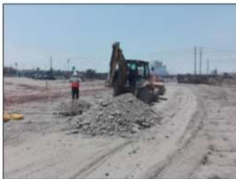
FOTO 11 Y 12 EN LAS VISTAS MOSTRADAS SE OBSERVA LA UBICACION DE LA CALICATA P-3. CONFORMADO POR SUELO LIMOSO LIGERAMENTE ARCILLOSO CON GRAVAS AISLADAS, SEMICOMPACTO, SUBYACIENDO SUELO GRAVOSO POBREMENTE GRADUADA, CON BOLONERIAS EN ESTADO SEMICOMPACTO.
