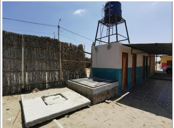
VISTA DEL PABELLÓN 05 DE SS.HH. SE APRECIA EL SISTEMA DE CISTERNA TANQUE ELEVADO, SE ENCUENTRA EN REGULAR ESTADO.
