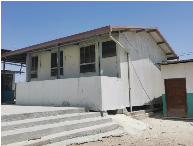
PABELLÓN 03, AULA PREFABRICADA INSTALADA EL AÑO 2017, SE APRECIA EL DESNIVEL ENTRE LA PLATAFORMA 01 Y LA ZONA DONDE SE UBICAN LOS BLOQUES 04,05 Y 06
