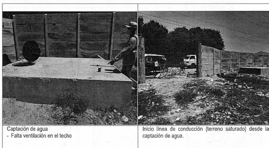
Figura N°2: Captación de agua y Línea de conducción
