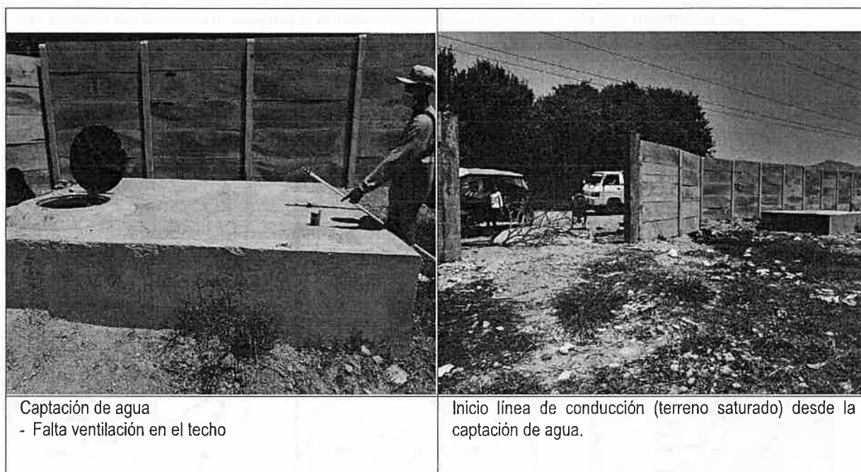
Figura N°2: Captación de agua y Línea de conducción
