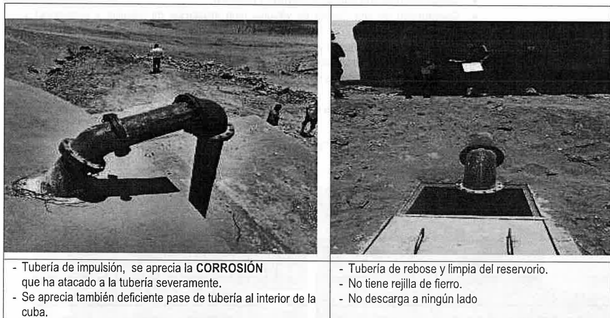
Figura N°6: Tubería de impulsión y tubería de rebose y limpia Reservorio
